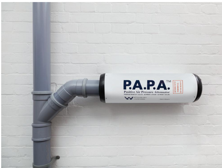
Kuva 31. Studor tuotevalmistajan P.A.P.A erikoisviemäriosa. (Turner 2012)
