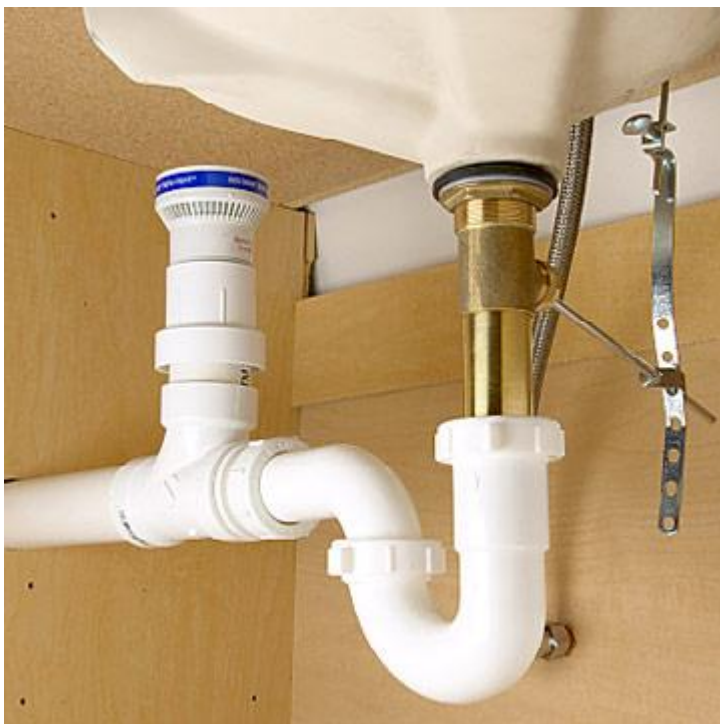
Kuva 29. Pesualtaan vesilukon suojaus AAV:tä käyttäen. ( Diyadvice www-sivut 2013)
