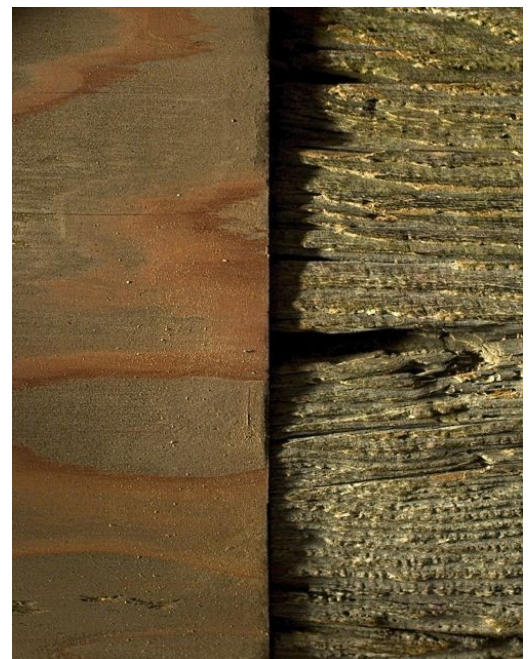
Kuvio 40: Uusi värjätty ja vanha harmaantunut ja mustaksi nokeentunut puu kohtaavat pilarissa.
