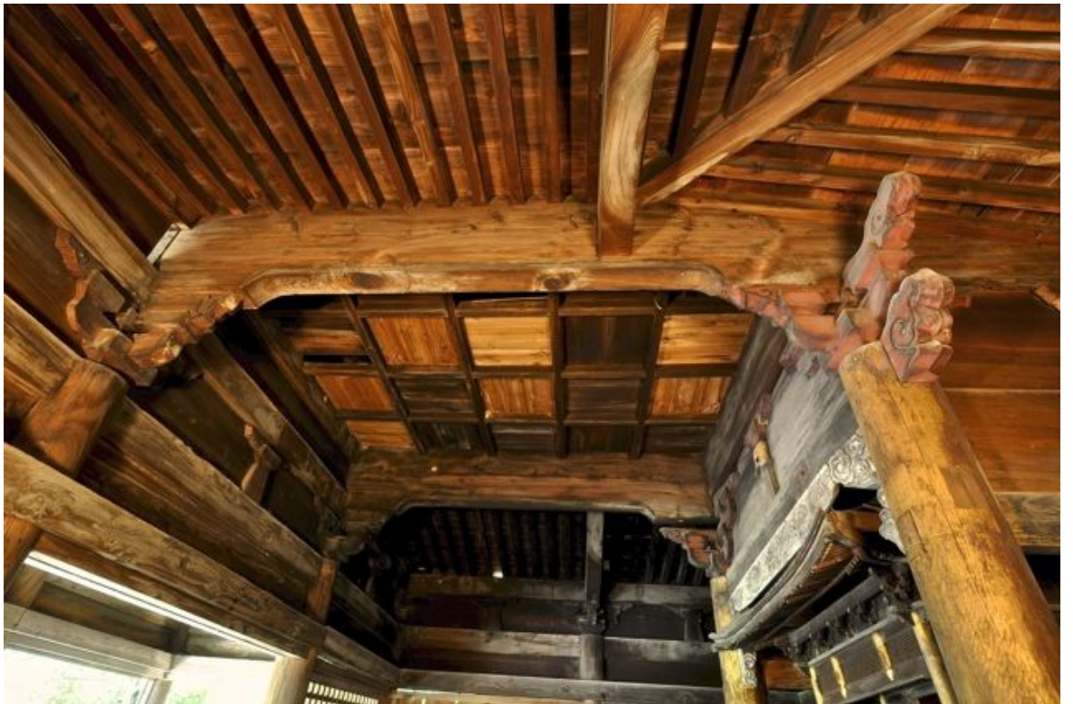
Kuvio 18: Temppelein sisäkattoa ennen purkamista, keskiosassa kasettikatto ja sivuilla rimalautakatto. Pääsisäänkäynti näkyy vasemmalla ja alttarin yläosaa oikealla.
