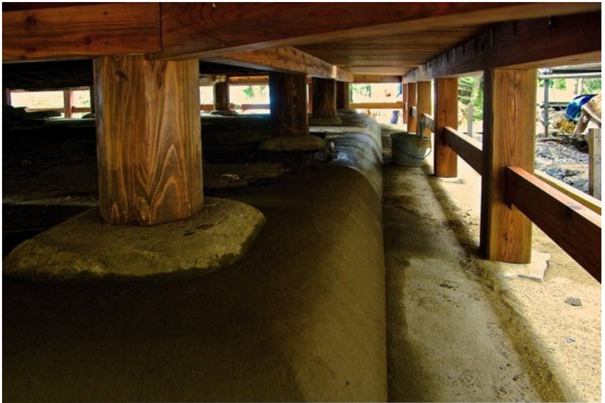
Kuvio 48: Terassin runko alta päin. Vasemmalla rakennuksen kantavia pilareita ja oikealla terassin rungon tolppia.
