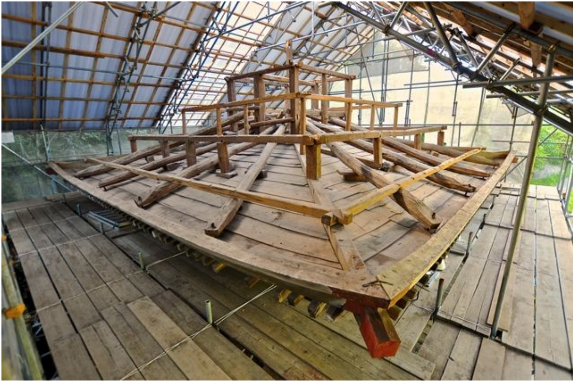
Kuvio 17. Katon alkuperäinen kantava rakenne laudasta tehdyn välikaton päällä. (Iwase Kenchiku 2011)
