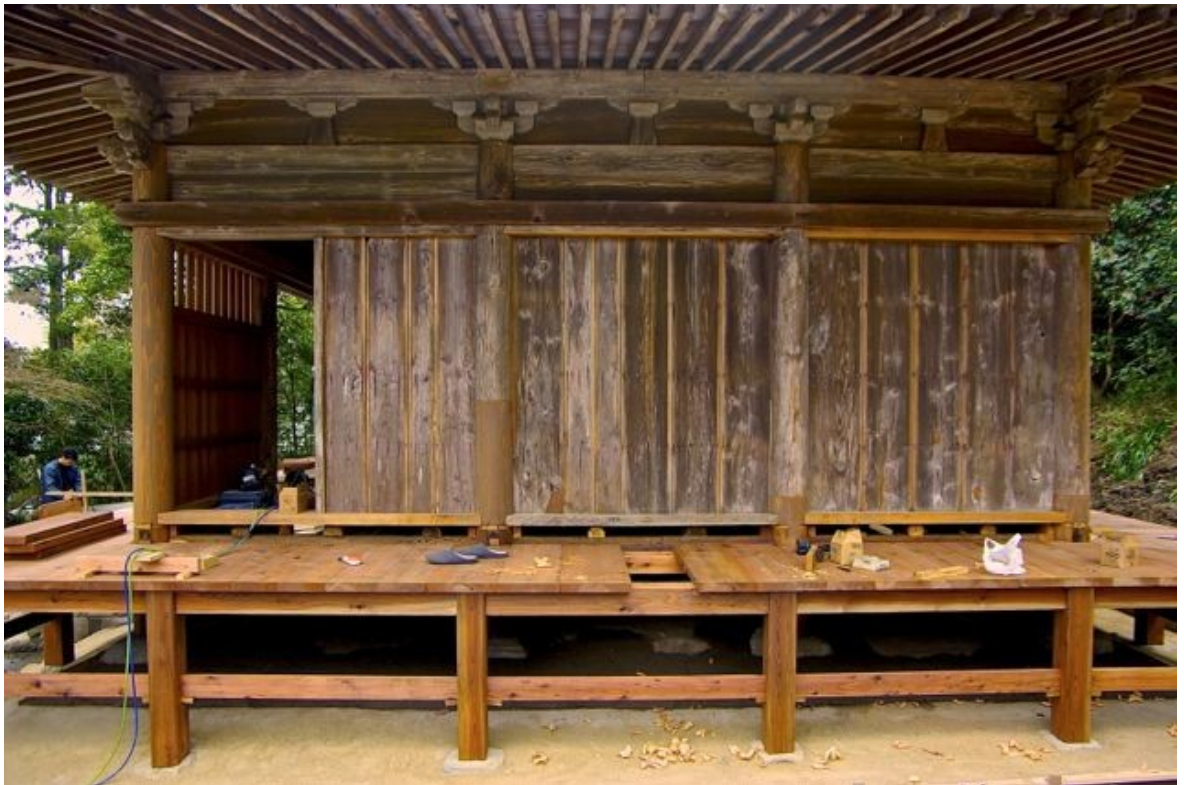
Kuvio 47: Terassin rungon osat kiinnitettiin liitoksilla ja puukiiloilla.
