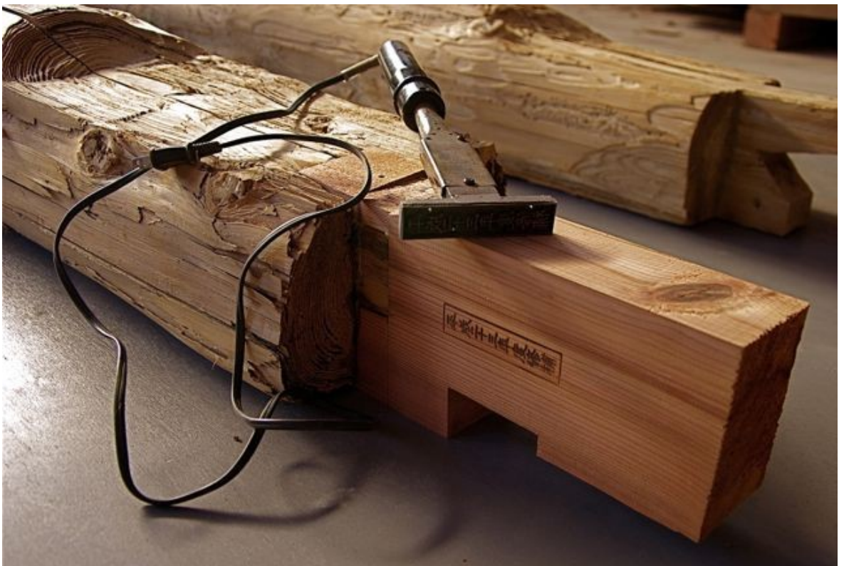
Kuvio 35: Korvausmateriaalista tehty lattianalaisen palkin pään liitos. Uuteen materiaaliin on merkitty polttomerkillä asennusvuosi, jolloin se erottuu selvästi vanhoista merkinnöistä.
