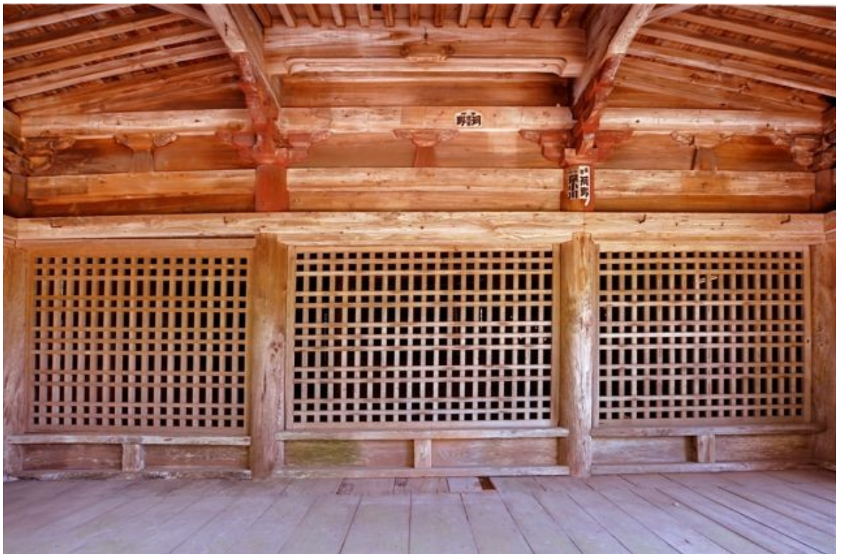
Kuvio 24: Alttarihuoneen ja "etuhuoneen" välinen kolmeosainen ristikkoseinä sisäänkäynnin suunnasta ennen konservoinnin aloittamista. (Iwase kenchiku 2011)
