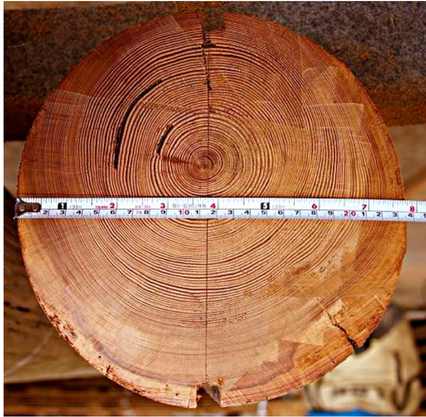
Kuvio 30: Alkuperäisen vanhan pilarin katkaistu pää.
