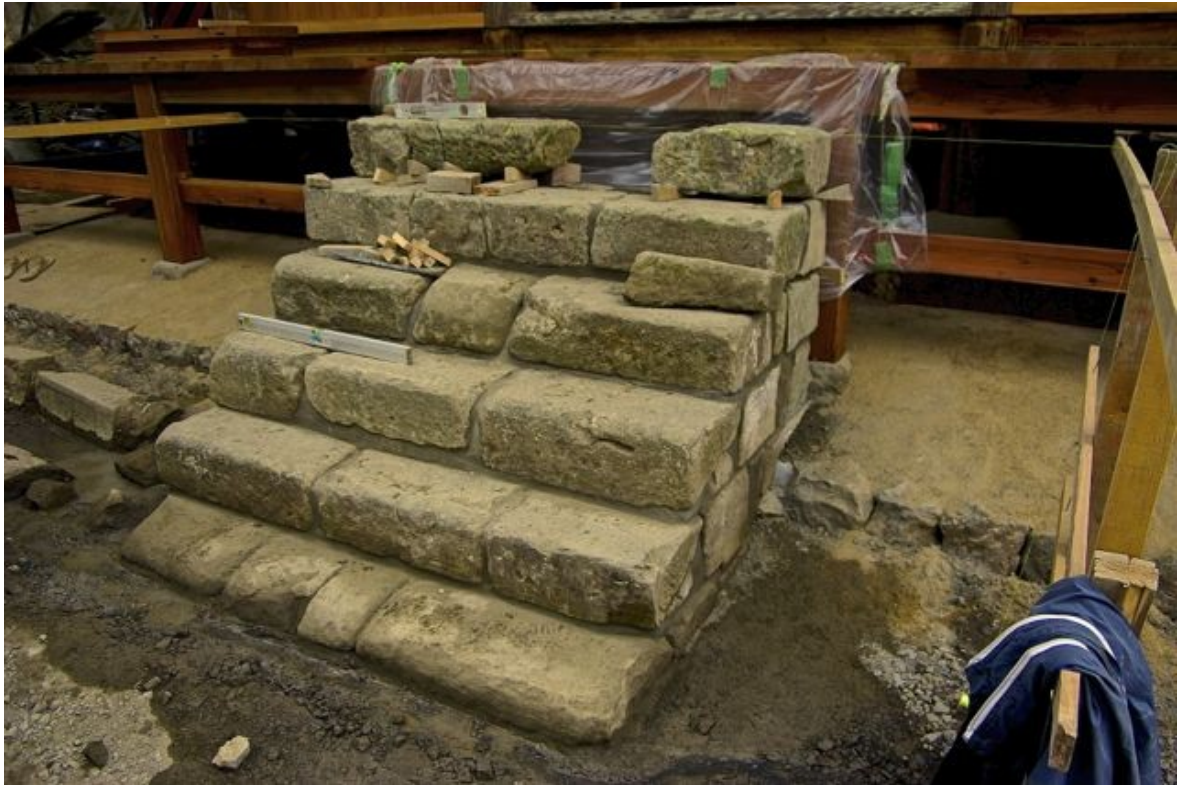
Kuvio 28: Kiviportaiden kaikki alkuperäiset kivet palautettiin rakenteeseen entisille paikoilleen.
