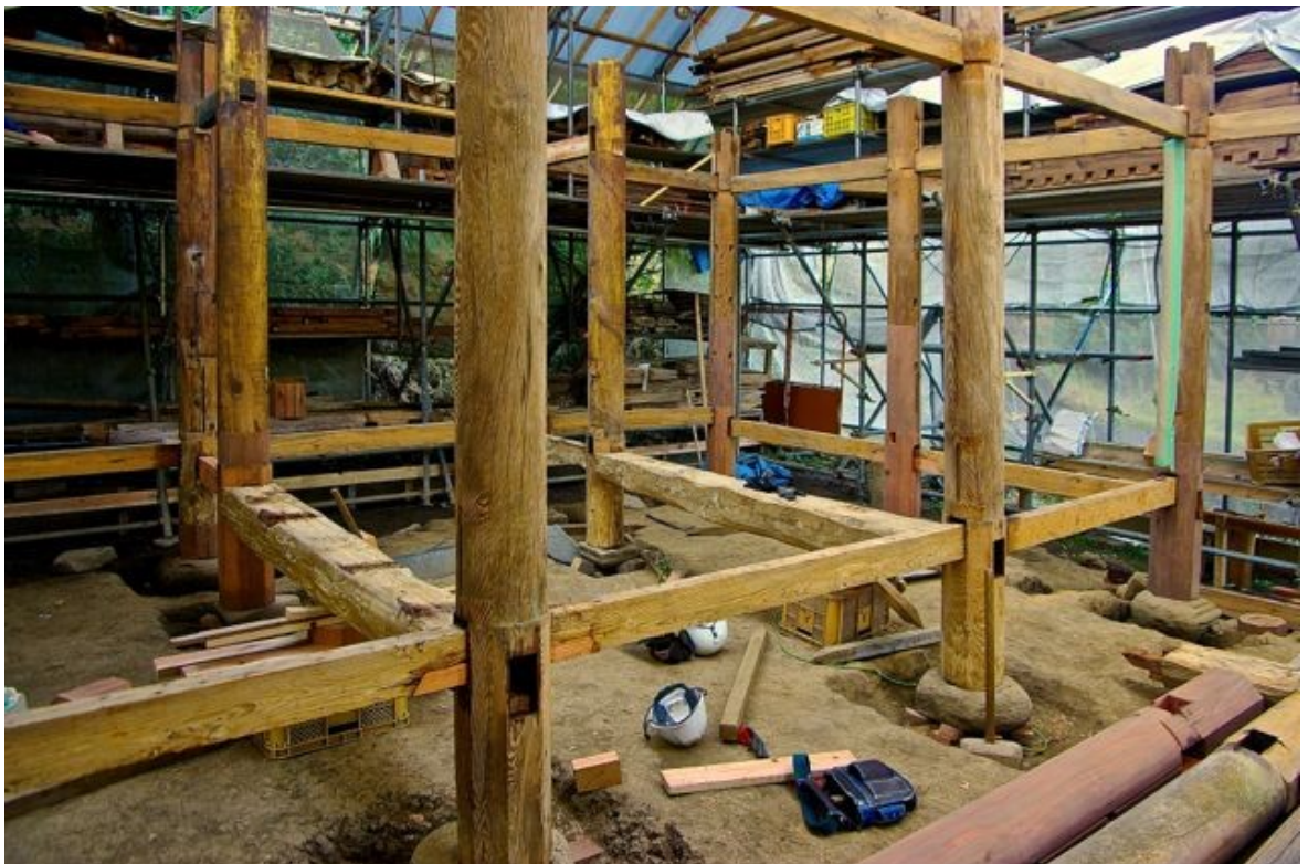
Kuvio 41: Uudelleen pystytettyä runkopilaristoa ja alhaalla etualalla vaakapalkki, josta yksityiskohta kuviossa 35. Oikealla maassa ainut rakenteeseen tullut kokonaan uusi punaiseksi värjätty pilari.
