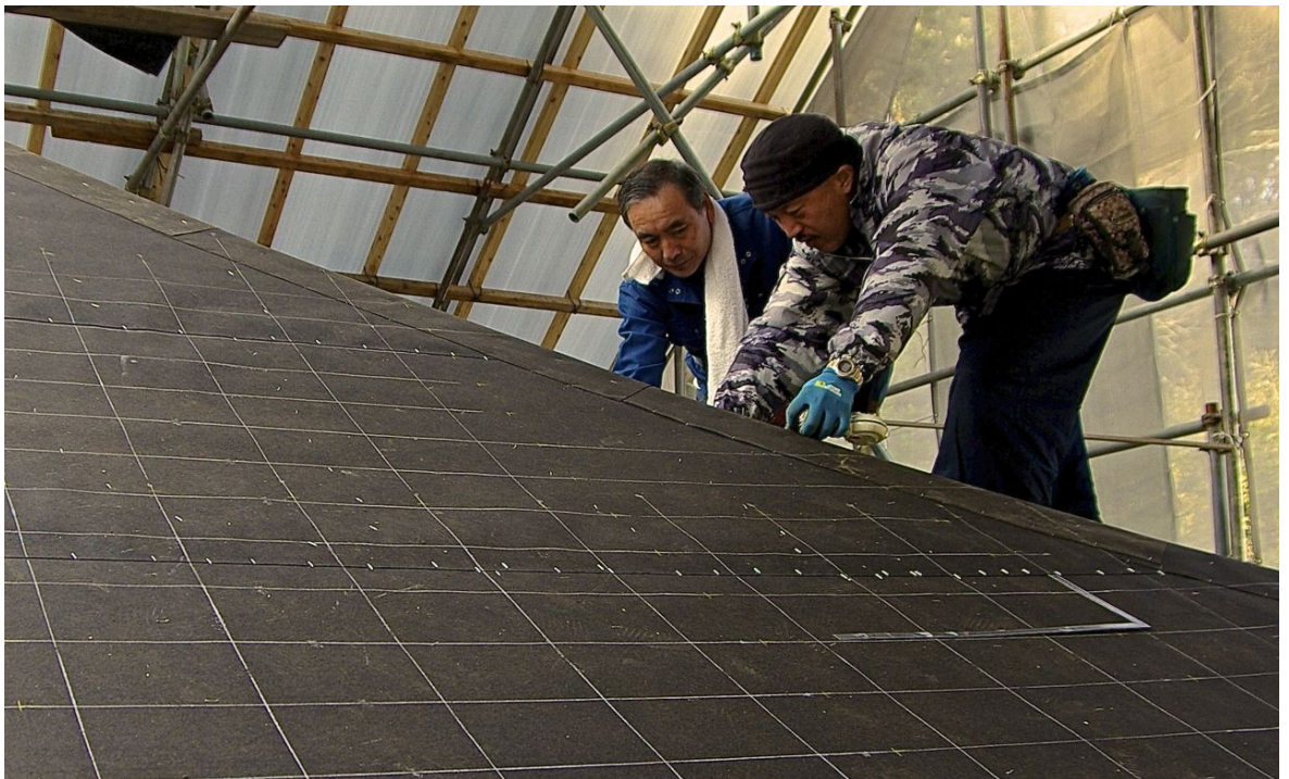
Kuvio 44: Kuparikaton tekijät työssään. Sumitsubolla tehdyt valkoiset linjat erottuvat hyvin tervapaperissa.
