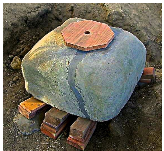
Kuvio 27: Perustuskivi (Kuviot 12, 26) puhdistettuna, korjattuna ja entiselle paikalleen asemituna.
