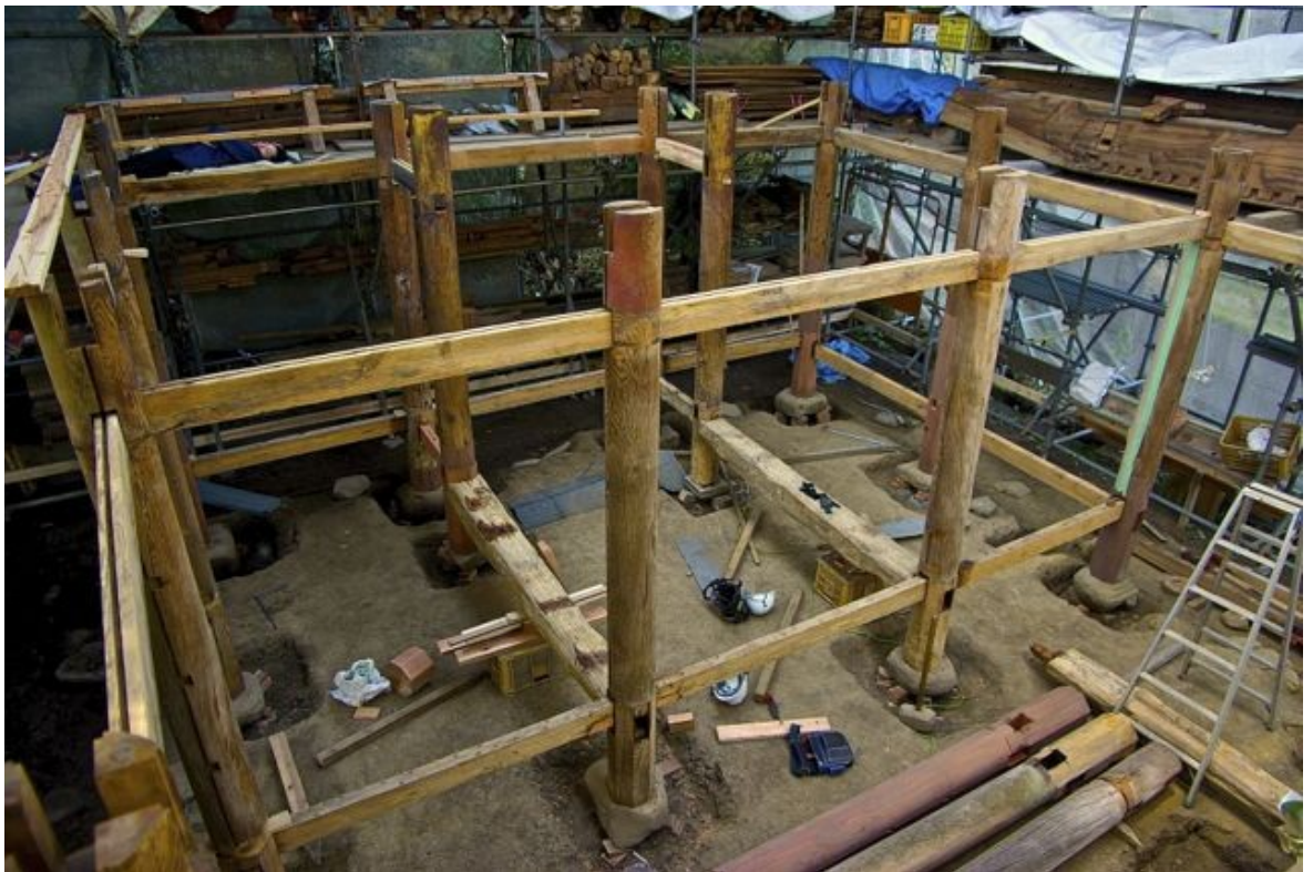
Kuvio 11. Tempelin uudelleen pystytettyä pilaristoa joulukuussa 2011.
