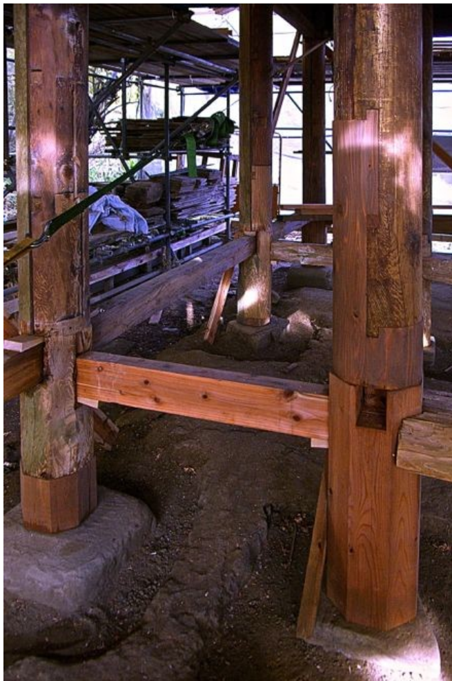
Kuvio 32: Oikean puoleisessa pilarissa on yleisesti käytetty perinteinen puuliitos, tässä uuden ja vanhan materiaalin välillä.
