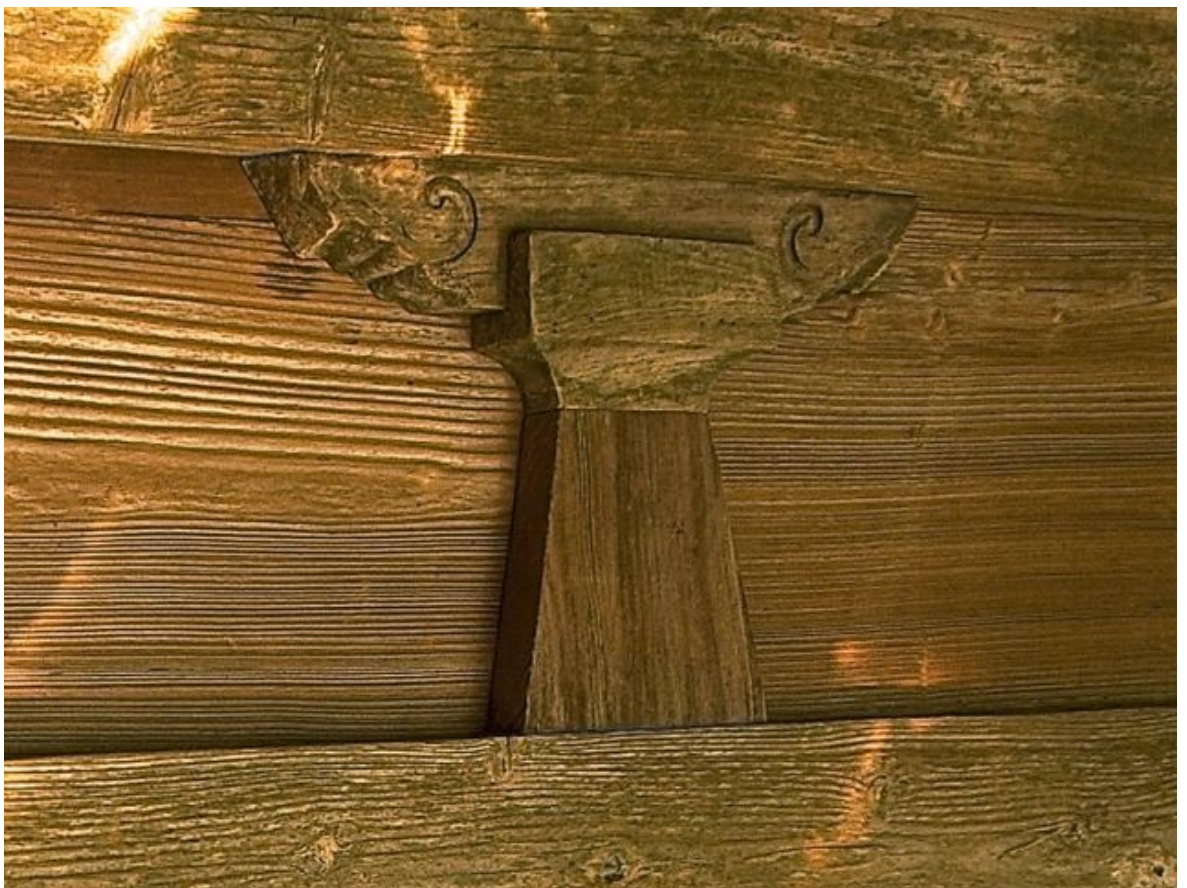
Kuvio 9. Rakenteessa paikallaan oleva kentozuka (間斗束) koostuu seitsemästä puuosasta.
