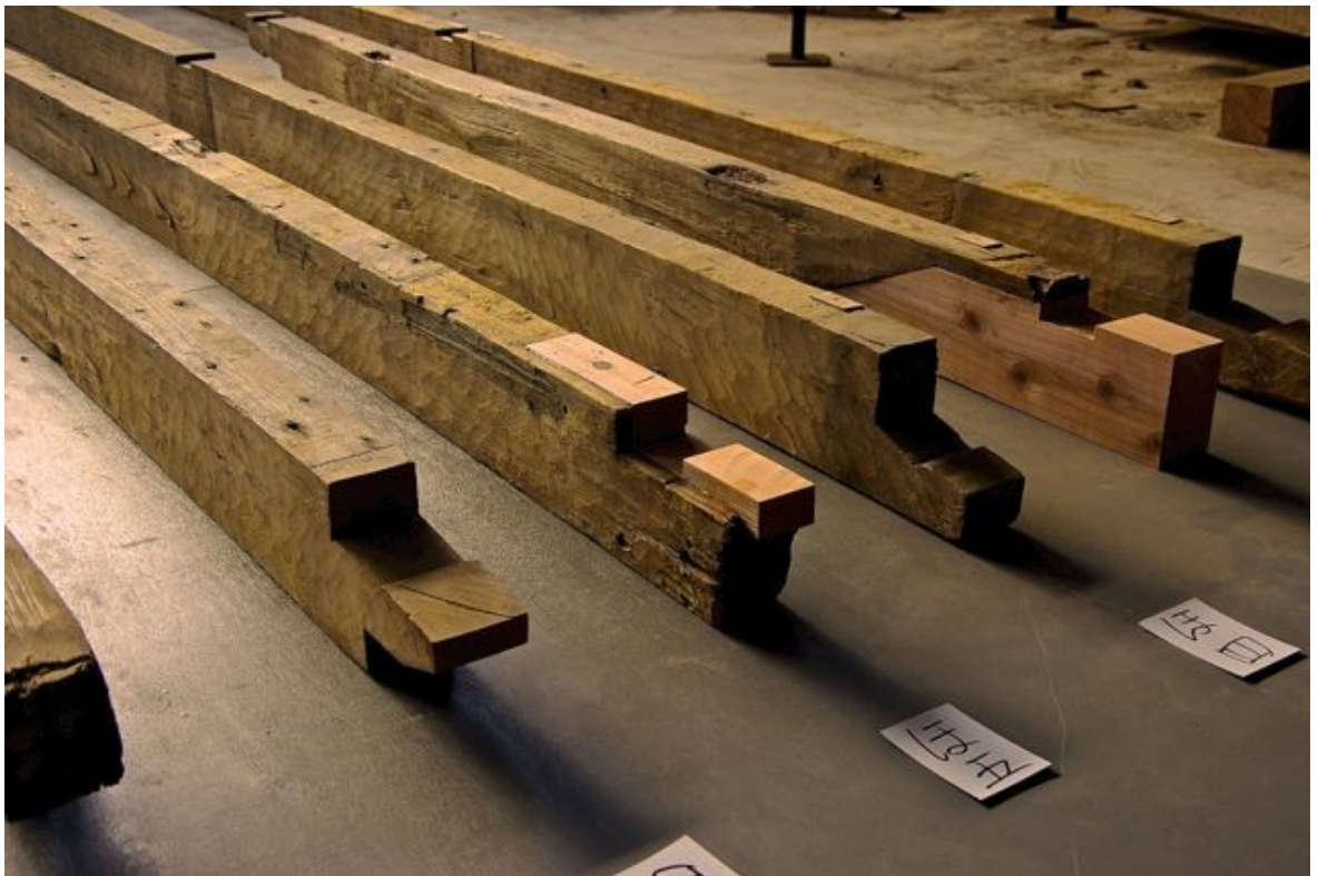
Kuvio 29: Korjattuja rungon alaosan vaakapalkkeja järjestettynä valokuvausta varten. Valkoiset laput kertovat palkin sijainnin rakenteessa. Palkkien pinnat on työstetty aikoinaan telsolla (poikkikirves, jap. chōna 鉋, 手斧).
