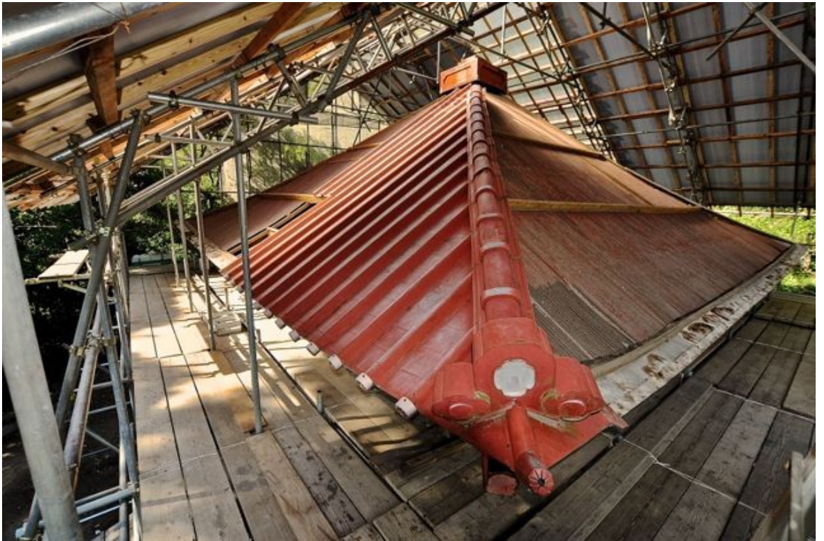
Kuvio 15. Aluskatteena olleen ruostuneen aaltopellin päältä on purettu osittain punaista vesikattopellitystä. (Iwase kenchiku 2011)
