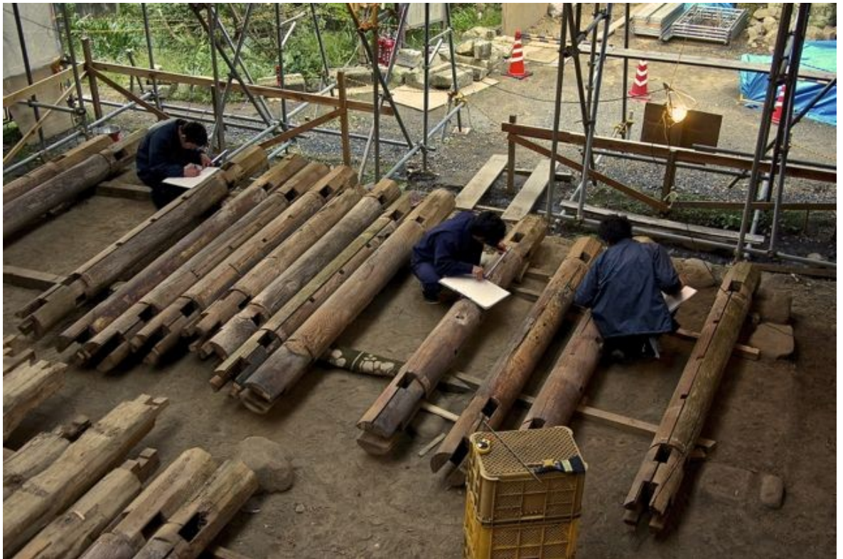
Kuvio 22: Pilareiden dokumentointi, merkintä ja tarkastaminen.
