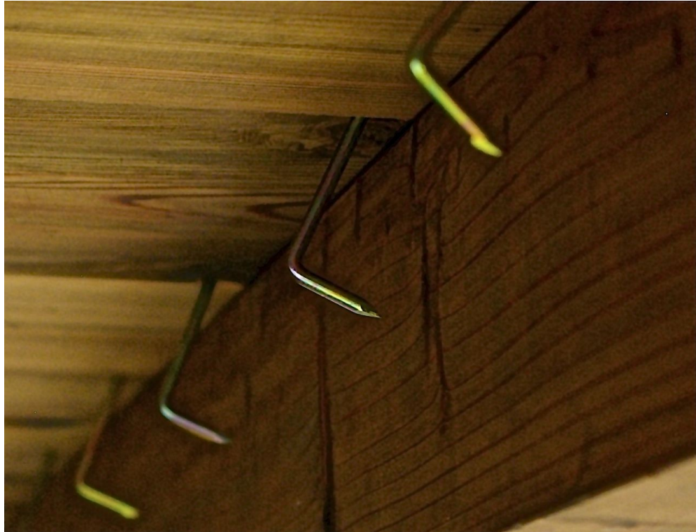
Kuvio 49: Terassin lattialankkujen kiinnityshakaset ennen paikalleen lyömistä.
