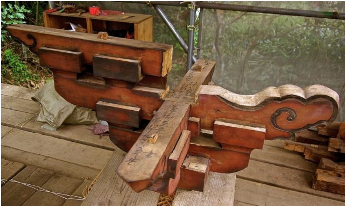
Kuvio 25: Uudelleen kasatun kumimono-osaen yläpinnassa näkyy vanhoja merkintöjä. Alimmaisen osan oikeassa kulmassa uusi sijaintia osoittava merkintälaatta.
