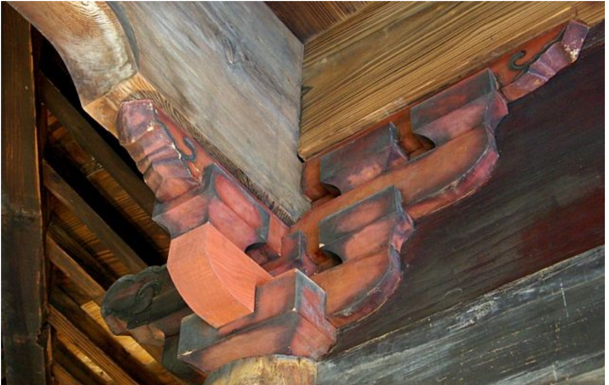
Kuvio 7. Kumimono-osaie kannattelee kattorakenteita. Se koostuu 28:sta puuosasta ja on lakattu japanilaisella punamullalla värjättyllä luonnonlakalla.
