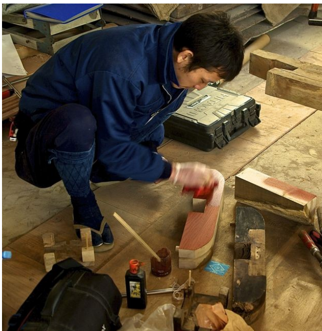
Kuvio 39: Pyhäkkökirvesmies Takakusa värjää uutta kumimonon osaa. Vieressä alkuperäinen, mustaksi nokeentunut ja hyönteisten pehmeäksi syövä osa.
