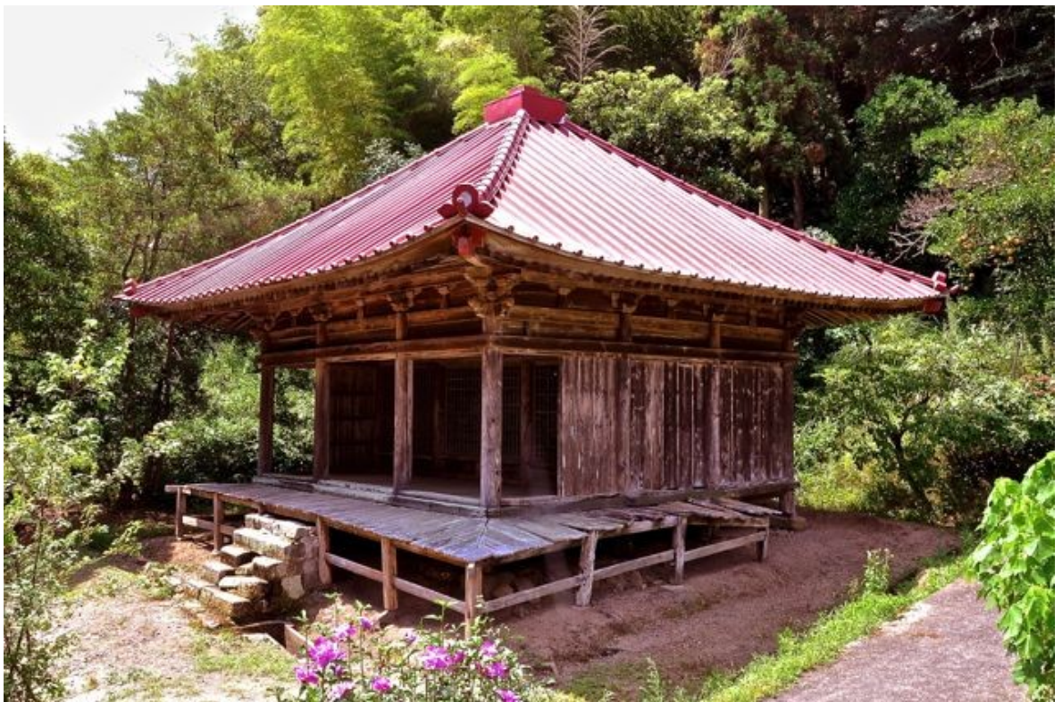
Kuvio 3. Temppeli ennen konservoinnin aloitusta elokuussa 2011 koillisesta kuvattuna. Julkisivun liukuovet on poistettu särkyneinä. (Iwase kenchiku 2011)
