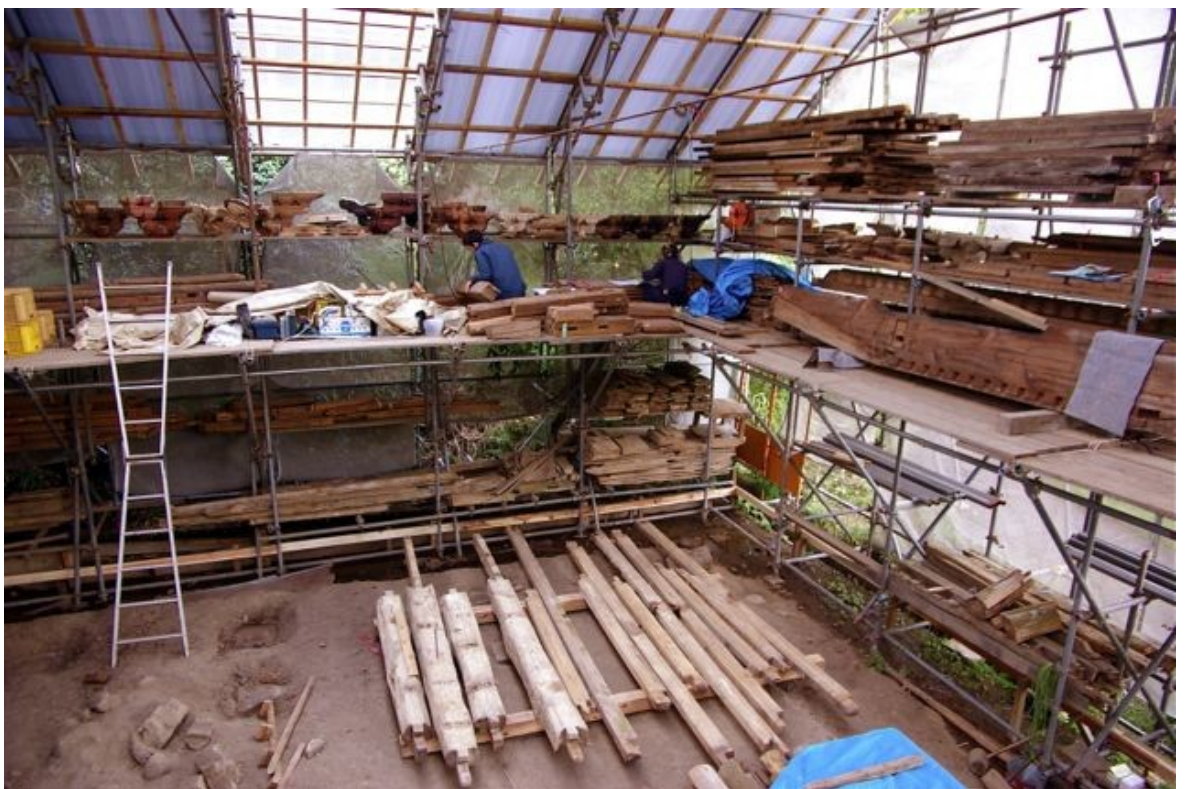
Kuvio 23: Kantavat lattian alaiset palkit maassa ja satoja rakennuksen osia suojarakennuksen hyllyillä odottamassa kuljetusta.
