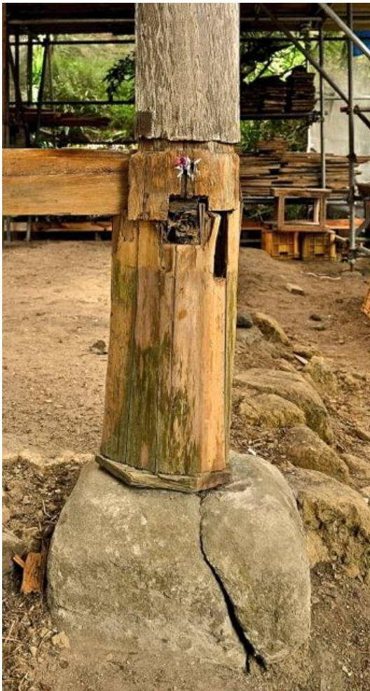
Kuvio 12. Tempppelin kulmapilarin perustuskivi on haljennut.
