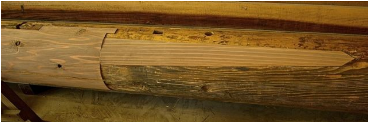
Kuvio 34: Pilarin tehty materiaalin vaihto ja liitos. Pilarissa on jäljellä vanhaa kultausta, jota ei uusittu osin esteettisistä, osin taloudellisista syistä.
