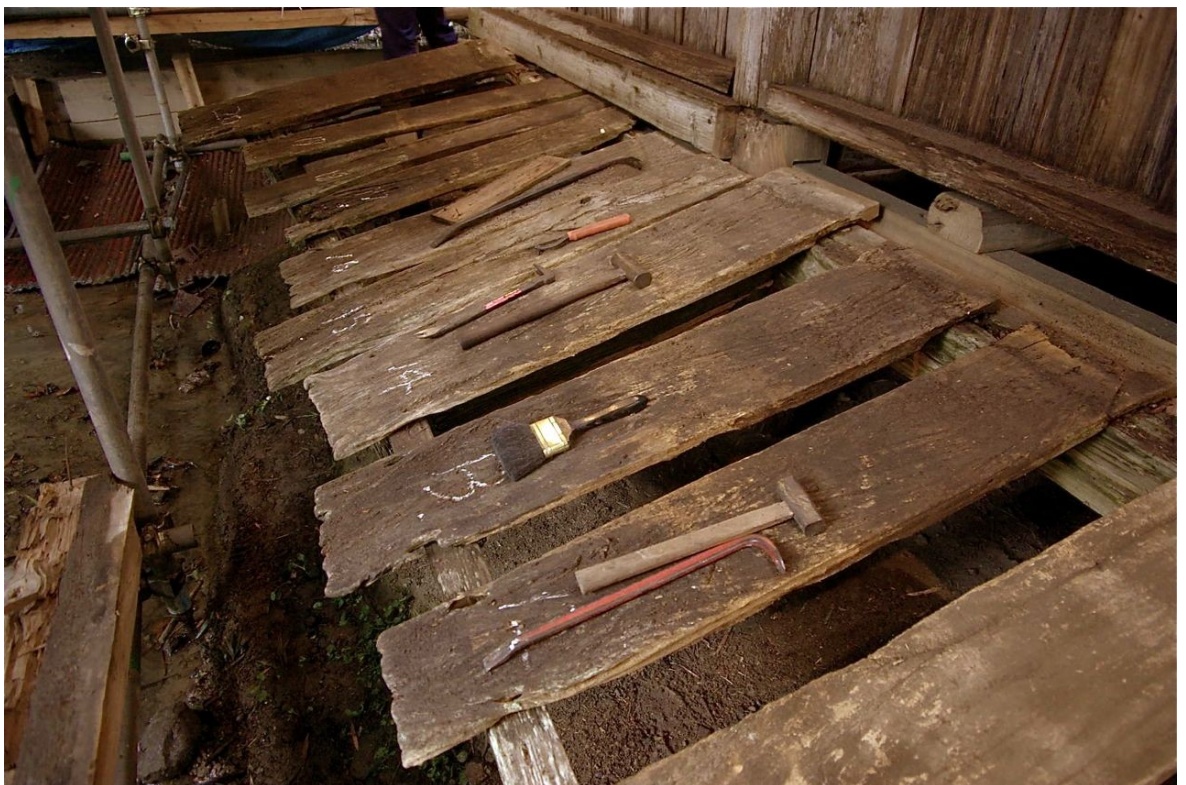
Kuvio 21: Kävelyterassin lattialautojen dokumentoinnissa jokaisen osan sijainti merkittiin osakarttaan.
