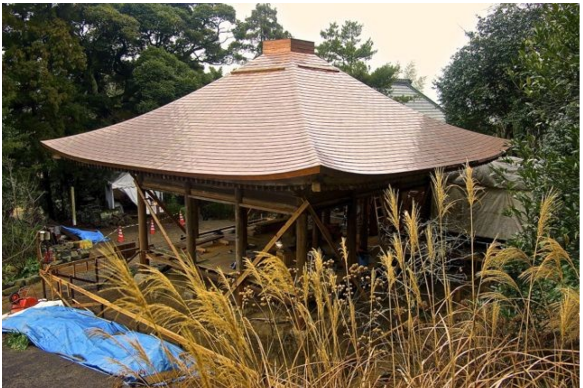
Kuvio 43. Temppeli luoteesta päin. Helmikuun lopussa 2012 kuparikatosta puuttuu vain huippuosa. Astintuet ovat vielä katolla.
