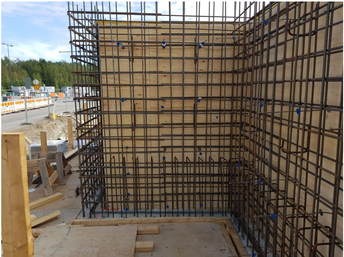
Kuva 3. Peittyvien raudoitteiden osalta tarkastus tehdään ennen toisen puolen muotin tekoa. Kuvassa väestönsuojan seinän raudoitus.
