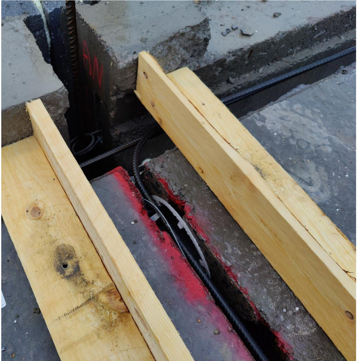
Kuva 2. Ennen talvella tapahtuvaa betonointia tarkastetaan muotti- ja betonipintojen puhtaus sekä varmistetaan, että pinnat ovat sulia.
