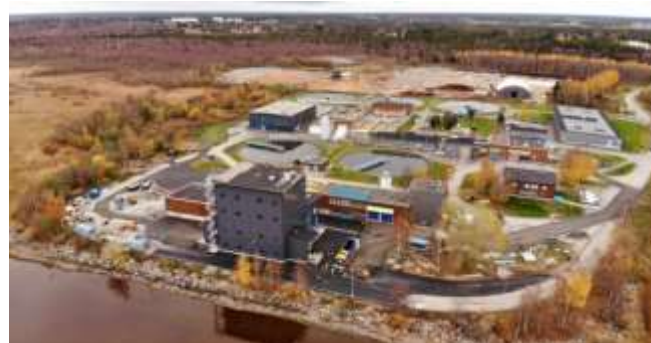
Taskilan jätevedenpuhdistamo (Oulun Vesi)
