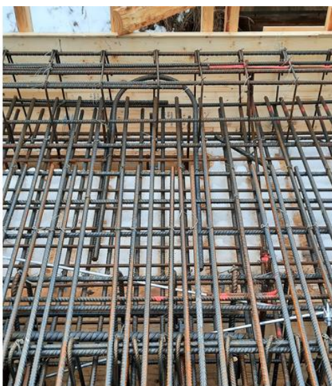
KUVA 31. Siltakannen ja reunapalkin raudoitusta uudiskohteessa (Vesalo, 2021)
