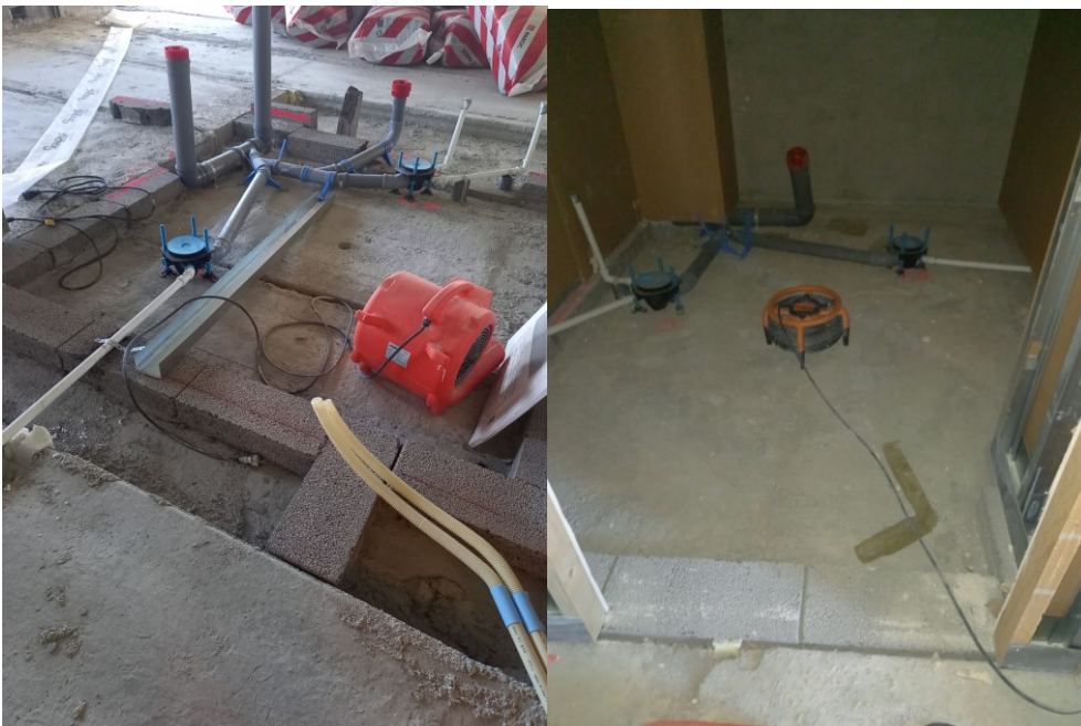
KUVA 5. Simpukka- ja aksiaalipuhallin
