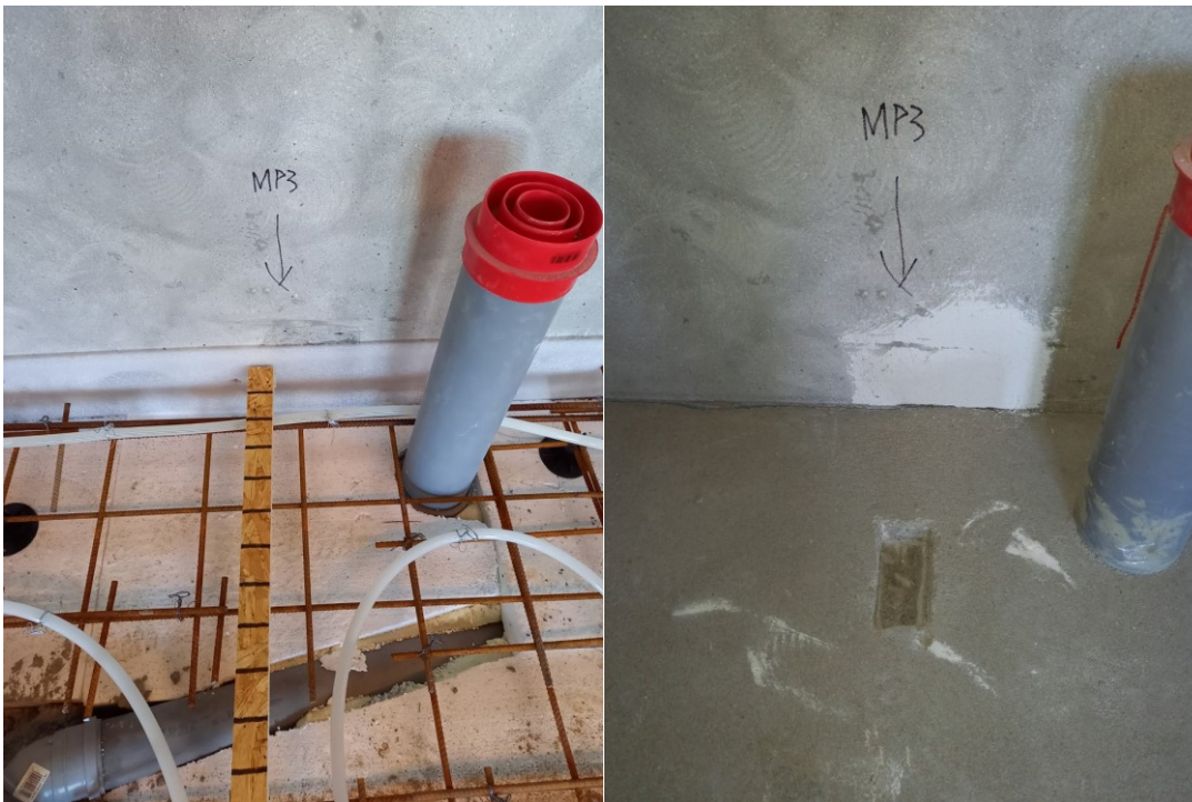
KUVA 11. Kosteusmittaus näytepalamenetelmällä maakostean betonin päältä (vasemmalla mittauspisteen merkintä ja oikealla näytepala on otettu kosteusmittausta varten)
