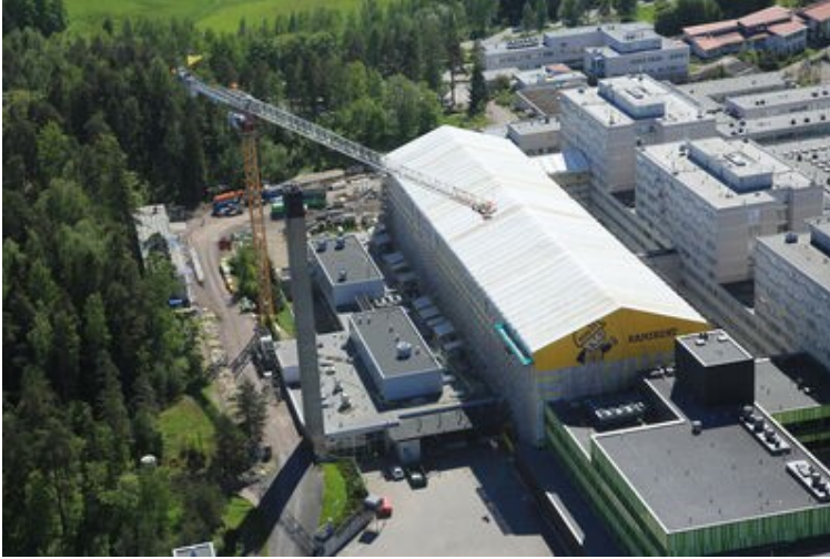
KUVA 12. KH Keder-sääsuoja asennetaan työkohteen päälle (9)
