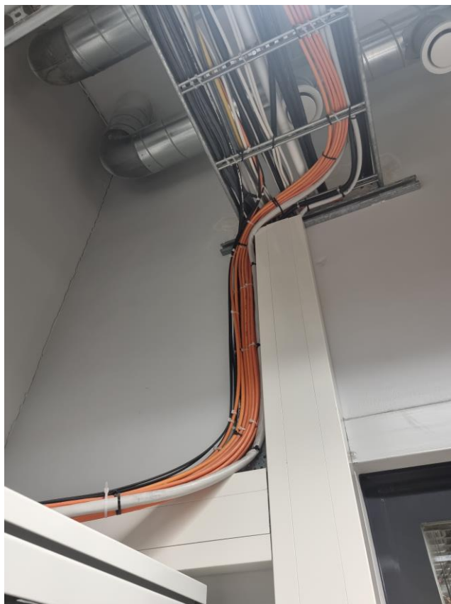
Kuva 10. Valokuitujen reititys jakamosta kaapelihyllylle.
