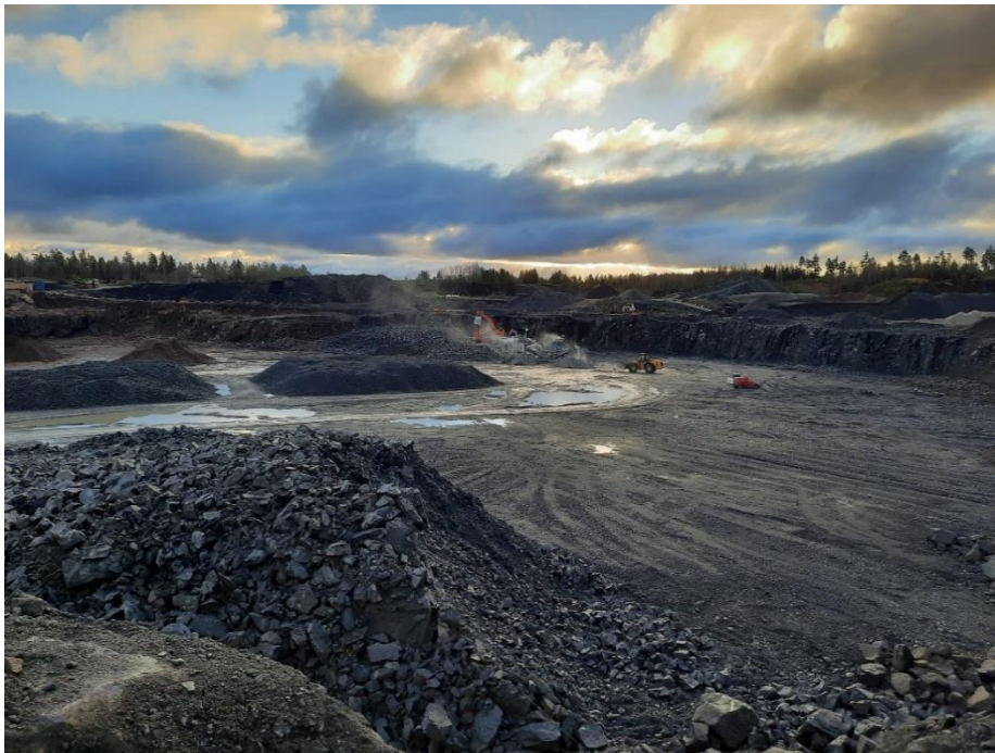
Kuva 1. Esimurskeen valmistusta Kone-Kostamo Oy:n ja Valtteri Varjonen Oy:n toimesta.
