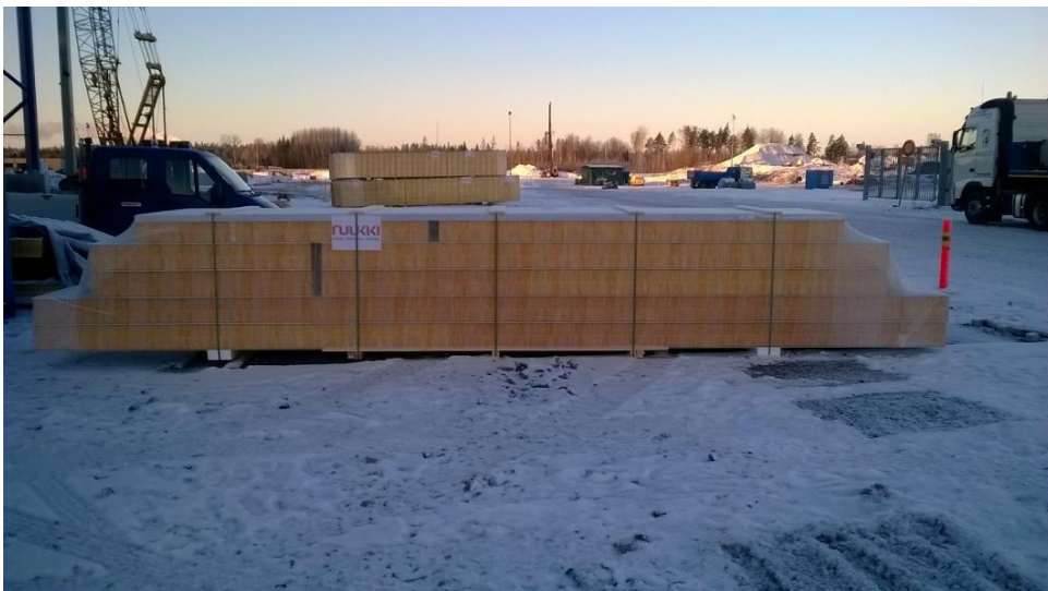
KUVA 1. Ruukin lämpimän rakennuksen elementtinippu
