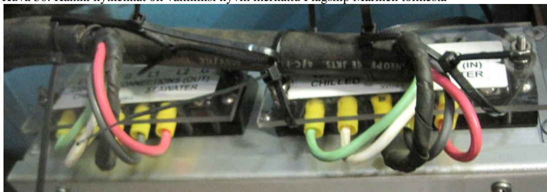
Kuva 31. Johdotukset kytkettiin perus liittimillä ja suojattiin kutistesukalla ja teipillä. Nippusiteisiin luotettiin ”väliaikaisessa” kiinnityksessä.
