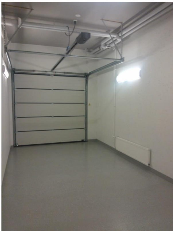
KUVA 19. Autotallin nosto-ovi (Vierikko 2013-09-16)
