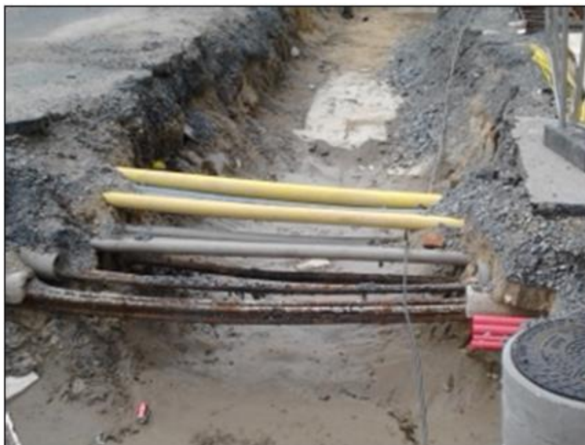
KUVA.8 APAKM-kaapelia torityömaalta, kaapelin sisällä kulkee ulkovalonohjaus mittakarvassa. (Kokkonen 2013.)
