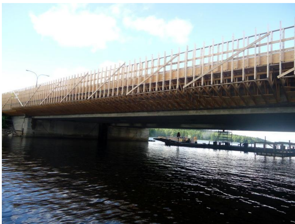
KUVA 4. Suosaaren siltojen muotti ja teline (Willman 2013-07-01.)
