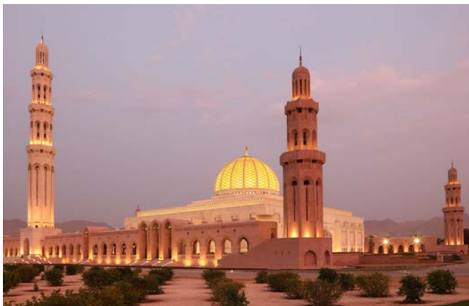
KUVA 4. Sultan Qaboos Grand Mosque (Layover guide 2012)
