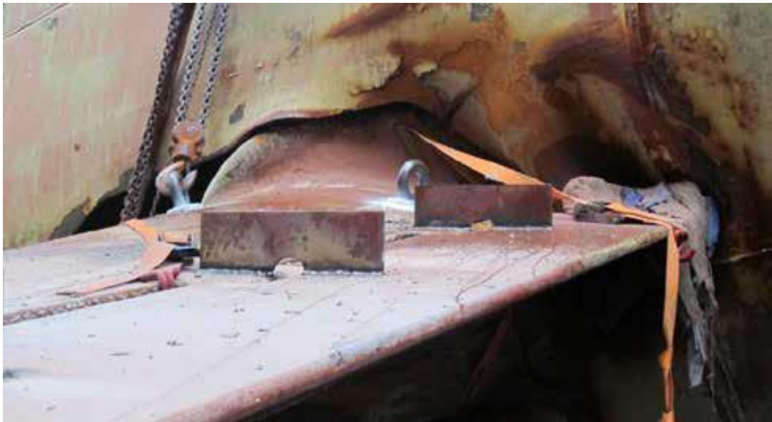
Kuva 12. M/S Finarrowin rungon ja vakaajan vauriokohta.
