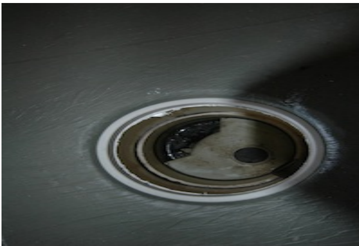
Kuva 17. Kiristerengas asennettuna vanhaan kaivoon.
