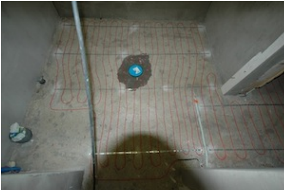
Kuva 3. Lattialämmityskaapelit ja termostaatin suojaputki asennettuna.
