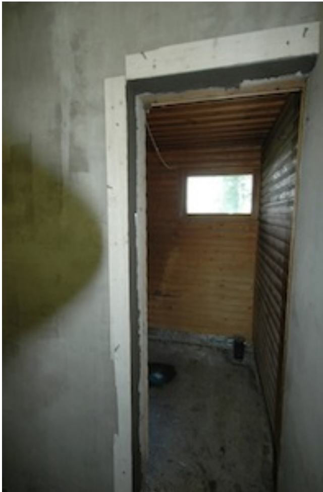
Kuva 8. Saunan ovipielet tasoitettuna ohjuri-lautaa käyttäen.
