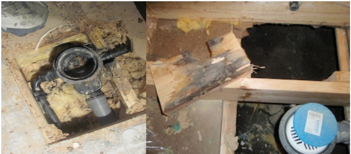
Kuva 10. Vanha kosteusvaurioitunut niskapalkki korvattuna uudella.
