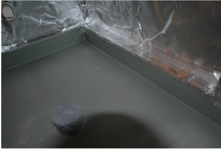
Kuva 19. Saunan ylösnoston tiivistys alumiiniteipillä vesieristykseen.
