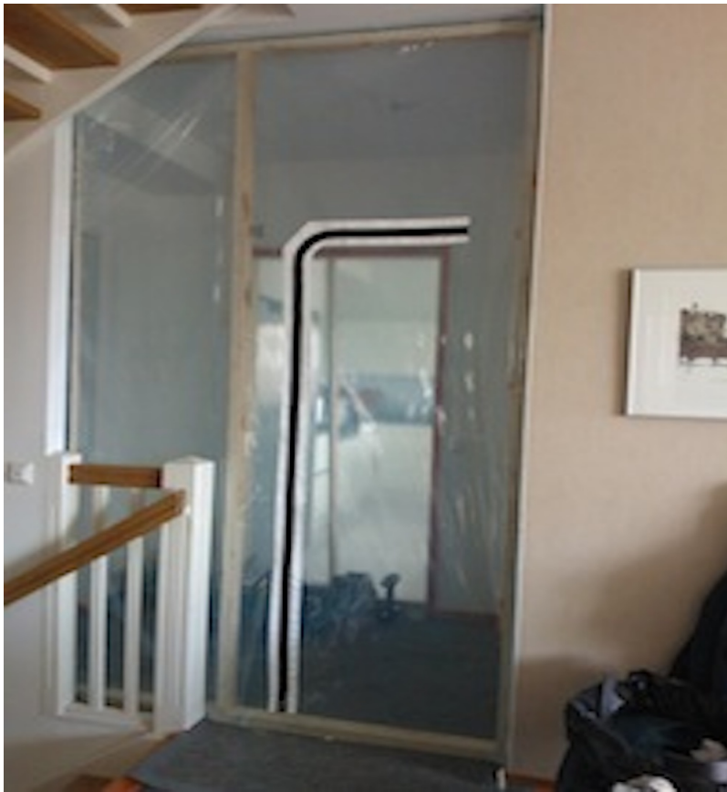
Kuva 1. Valmis vessaremontin osastointi ja suojaus.
