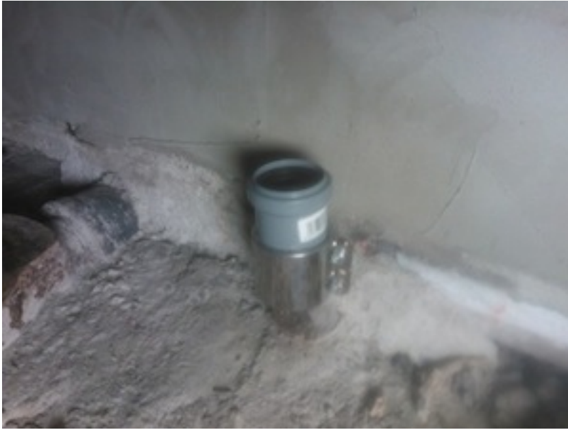
Kuva 5. Jatkettu lavuaarin poistoputki.
