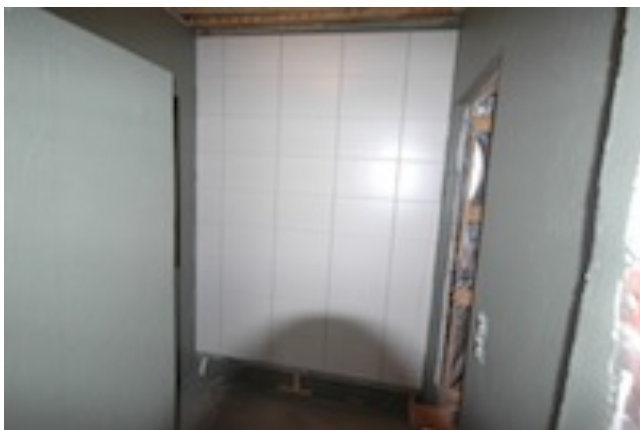
Kuva 20. Säädettävän aloitusriman päältä aloitettu seinälaatoitus.
