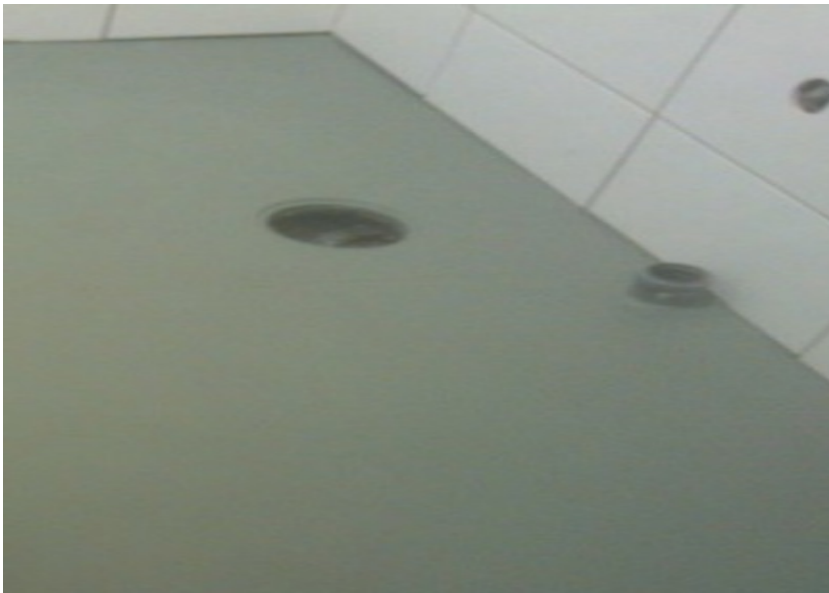
Kuva 6. Valmis vesieristys ennen lattialaatoitusta.
