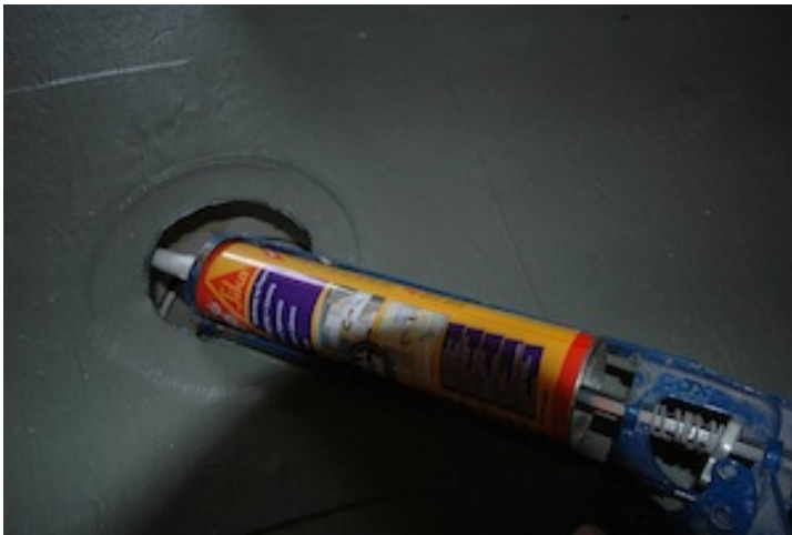
Kuva 16. Kaivon sisäpintaan asennetaan liimatiivistemassa ennen kiristerenkaan asennusta.
