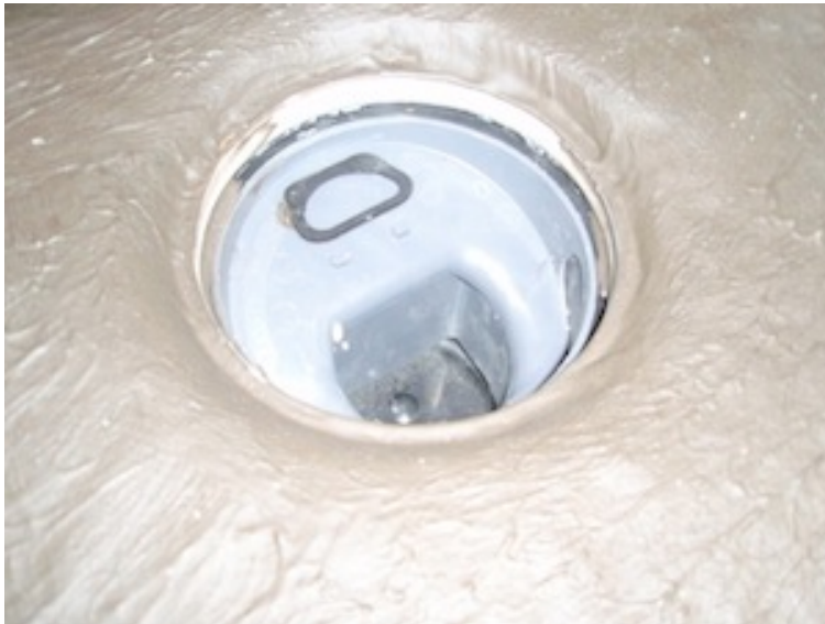
Kuva 13. Uuden kaivon ja vesieristeen liitos. (ARDEX 8 + 9 - järjestelmällä)
