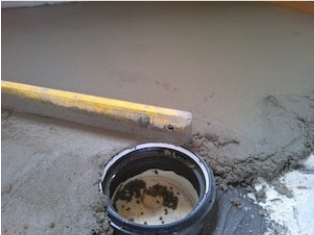
Kuva 11. Uusien kaatojen valu käynnissä.
