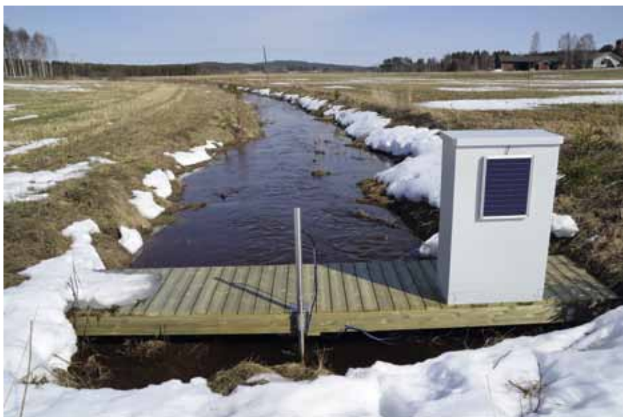
KUVA 1. Mittauslaitteet asennettiin siltarakenteisiin. (Kuva: Samuli Lahtela, JAMK.)
