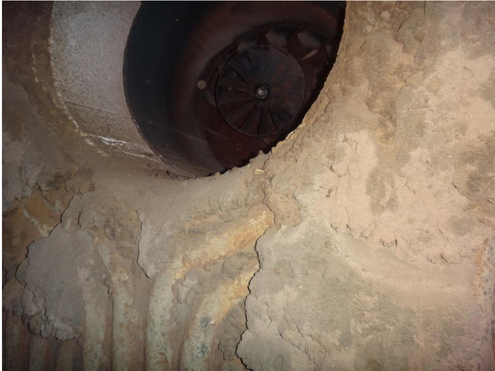
Kuva 28. Vaurioitunut muuraus
