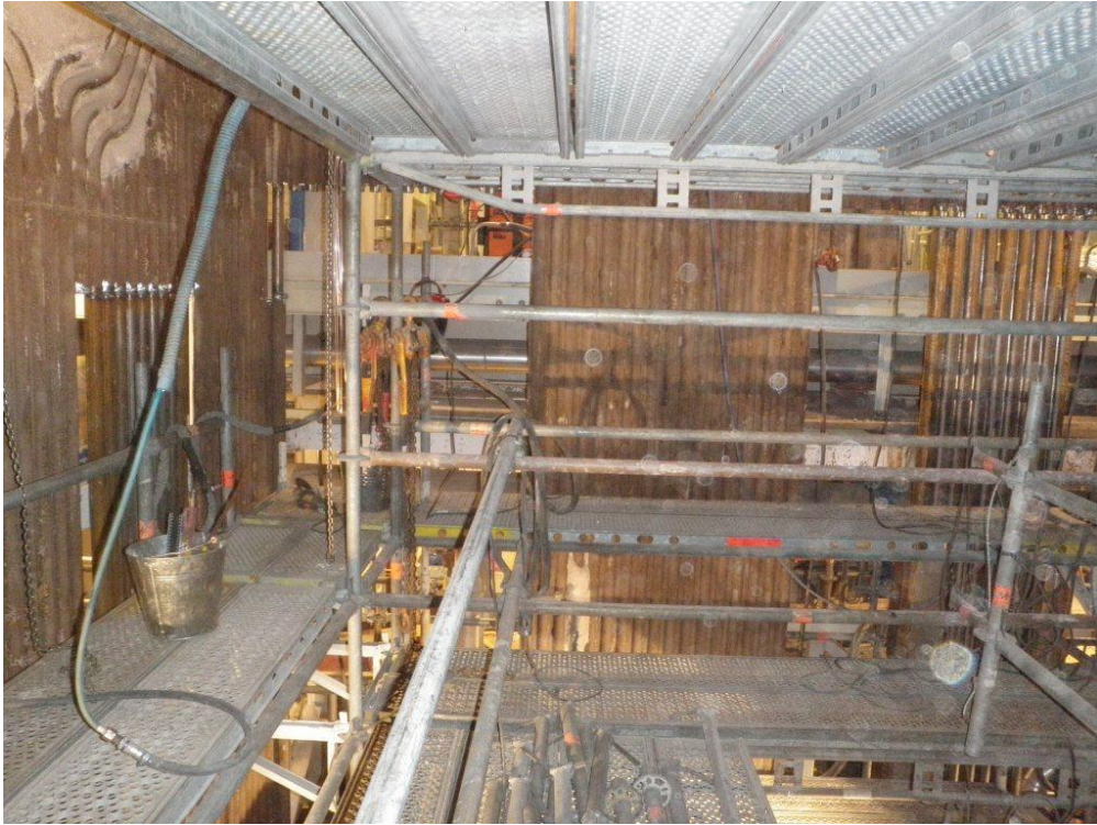
Kuva 33. Näkymä tulipesän seinänvaihtotyömaasta
