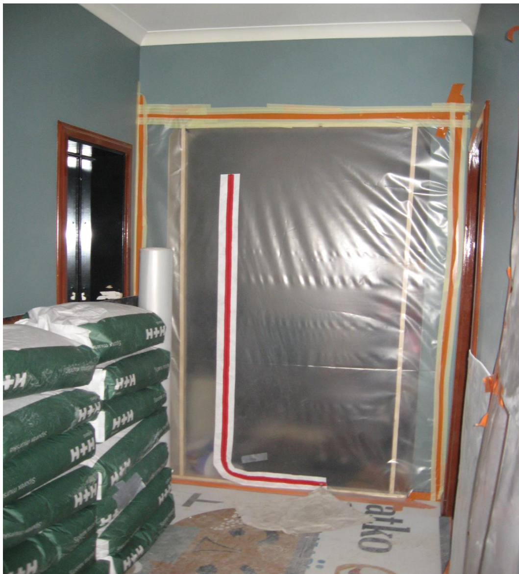
Kuva 1. Kuva suojaseinästä ja lattian suojauksista. Kuva Jarkko Heikkinen.
