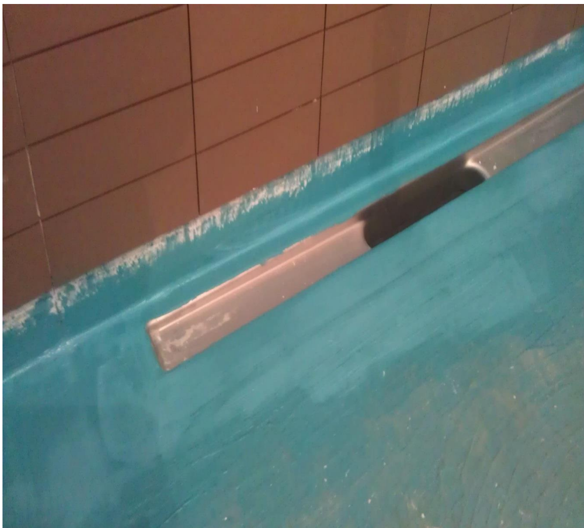
Kuva 7. Lattian vedeneristäminen. Lattiakaivojen vedeneristäminen tulee tehdä huolella, ettei vesi pääse väärään paikkaan. Kuva Arto Kempainen.
