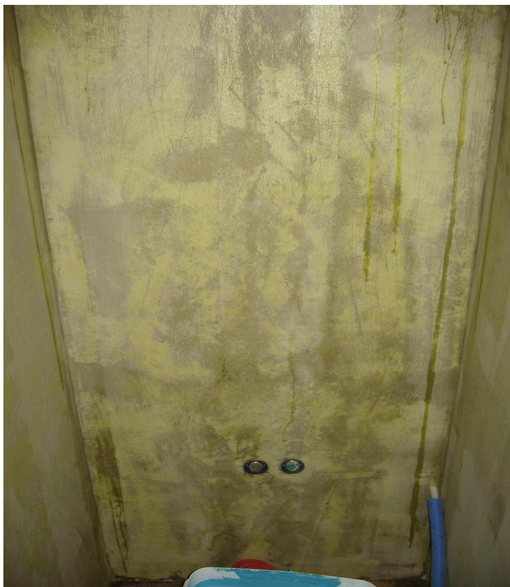
Kuva 4. Tasoitettu seinäpinta, joka on käsitelty primerilla. Valmis vedeneristettäväksi.
