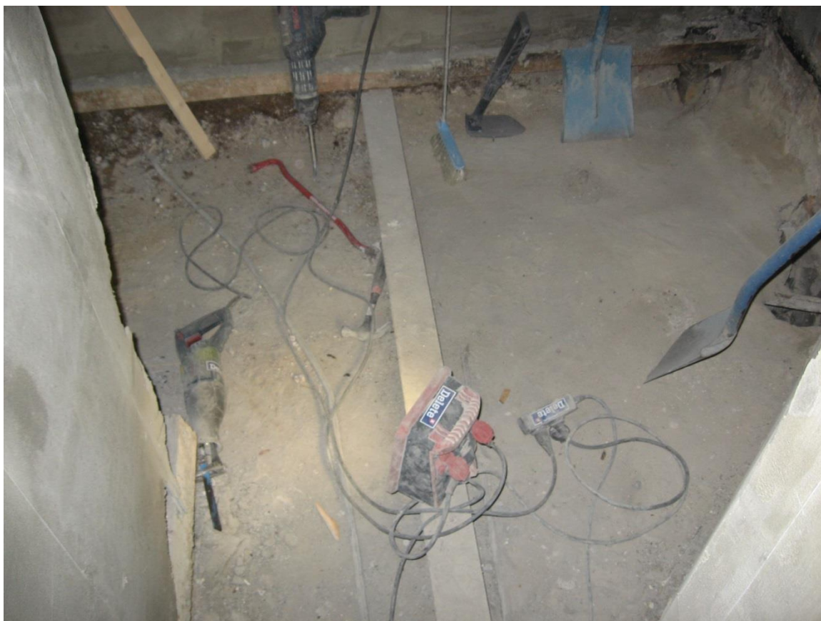
Kuva 2. Märkätilan lattianpurkutyöt. Kuva Jarkko Heikkinen.
