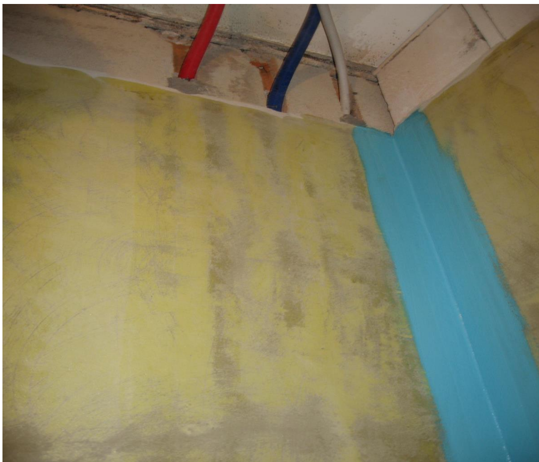
Kuva 5. Nurkan vedeneristys. Nurkka on vahvistettu vahvikenauhalla. Kuva Jarkko Heikkinen.
