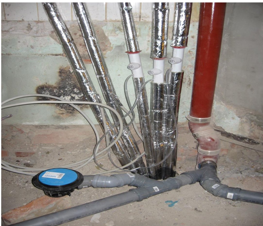
Kuva 12. Uudet vesi- ja viemärivedot, sekä uusi lattiakaivo. Kuva Jarkko Heikkinen.
