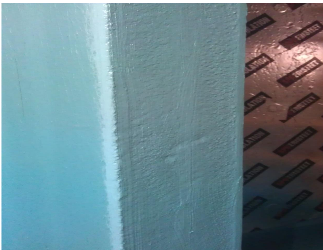
Kuva 6. Seinän päädyn ja seinän vedeneristys. Kuva Arto Kempainen.
