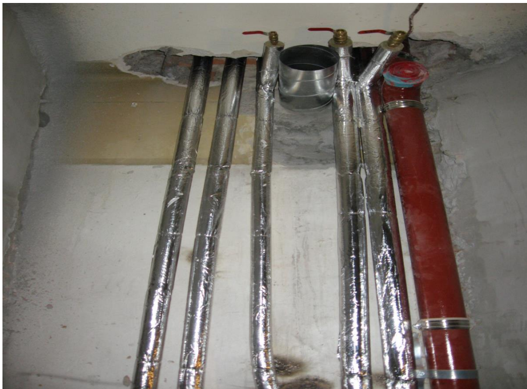
Kuva 11. Uudet vesi- ja viemärijohdot, sekä ilmastointiputki. Kuva Jarkko Heikkinen.
