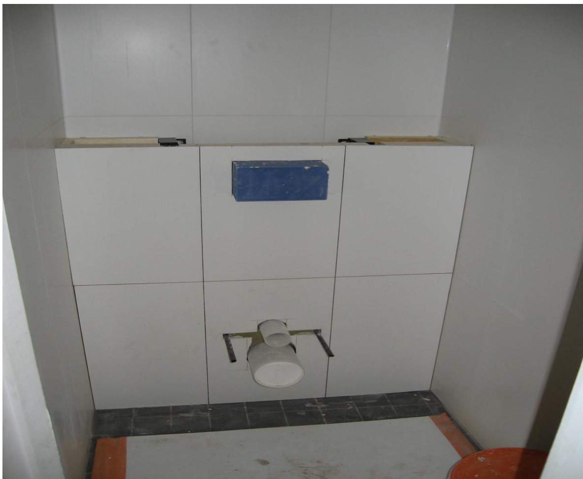
Kuva 8. Laattojen asennus wc-pöntön taakse tulevaan koteloon. Kuva Jarkko Heikkinen.
