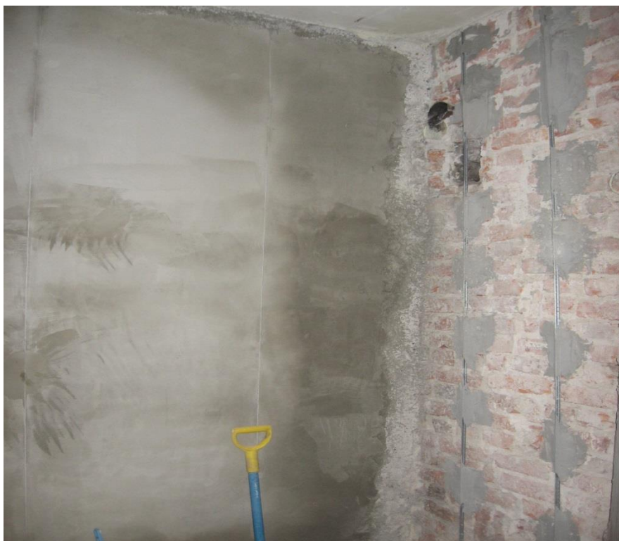
Kuva 3. Tasoitustyöt. Kuva Jarkko Heikkinen.
