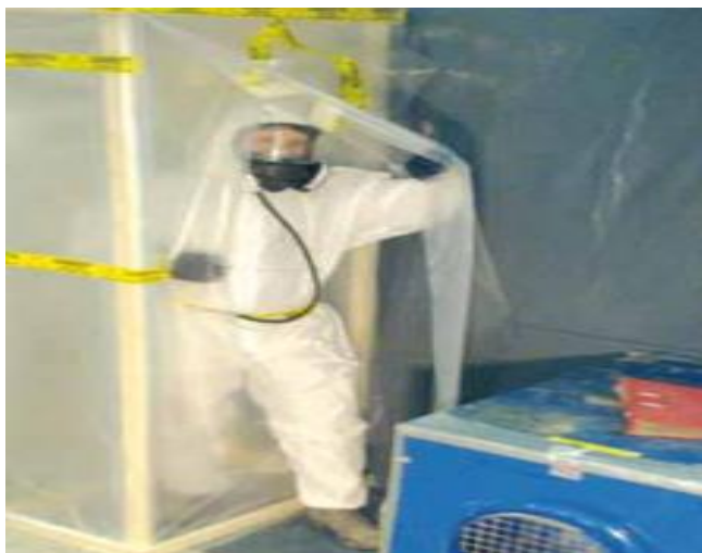
Kuva 2. Osastoinnin sisäänkäynnin rakenne. [17]
