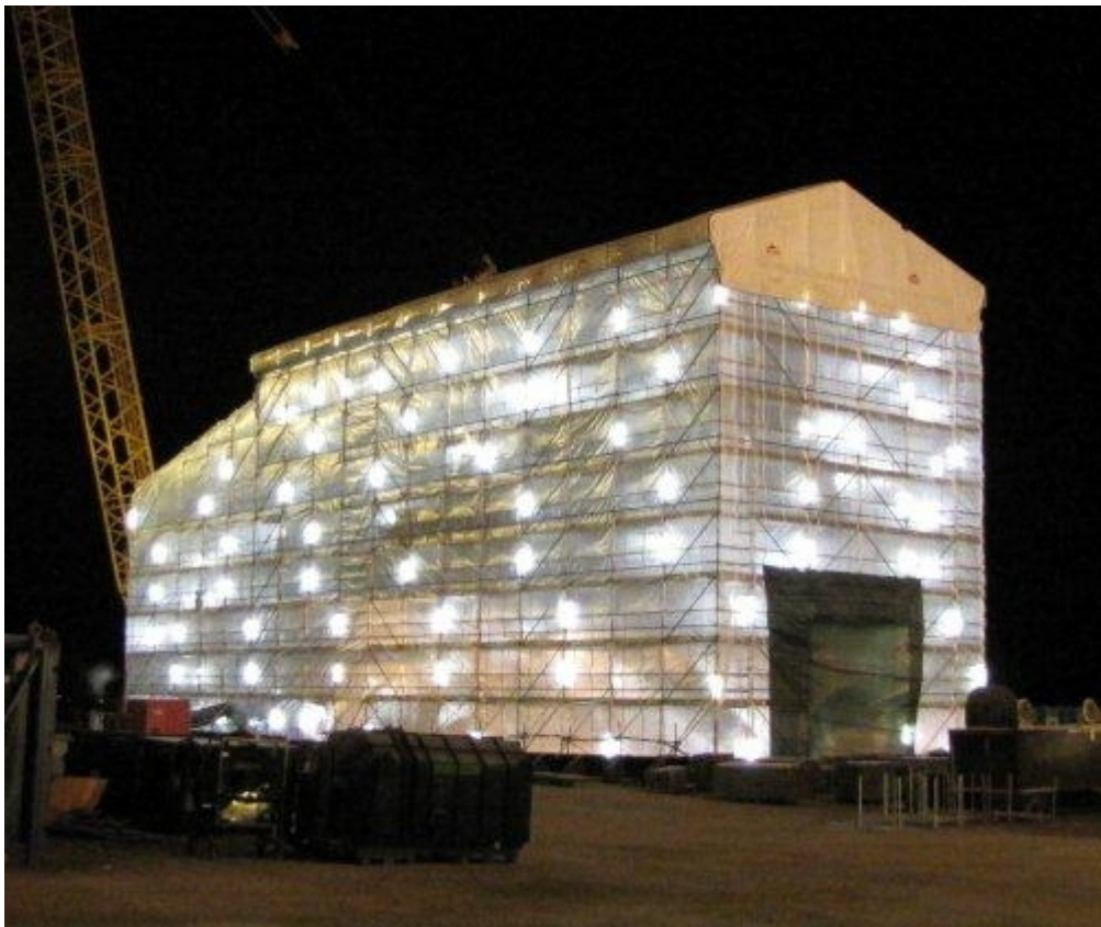
Kuva 10. Säätasuojateltan alla rakentamista. [37.]
