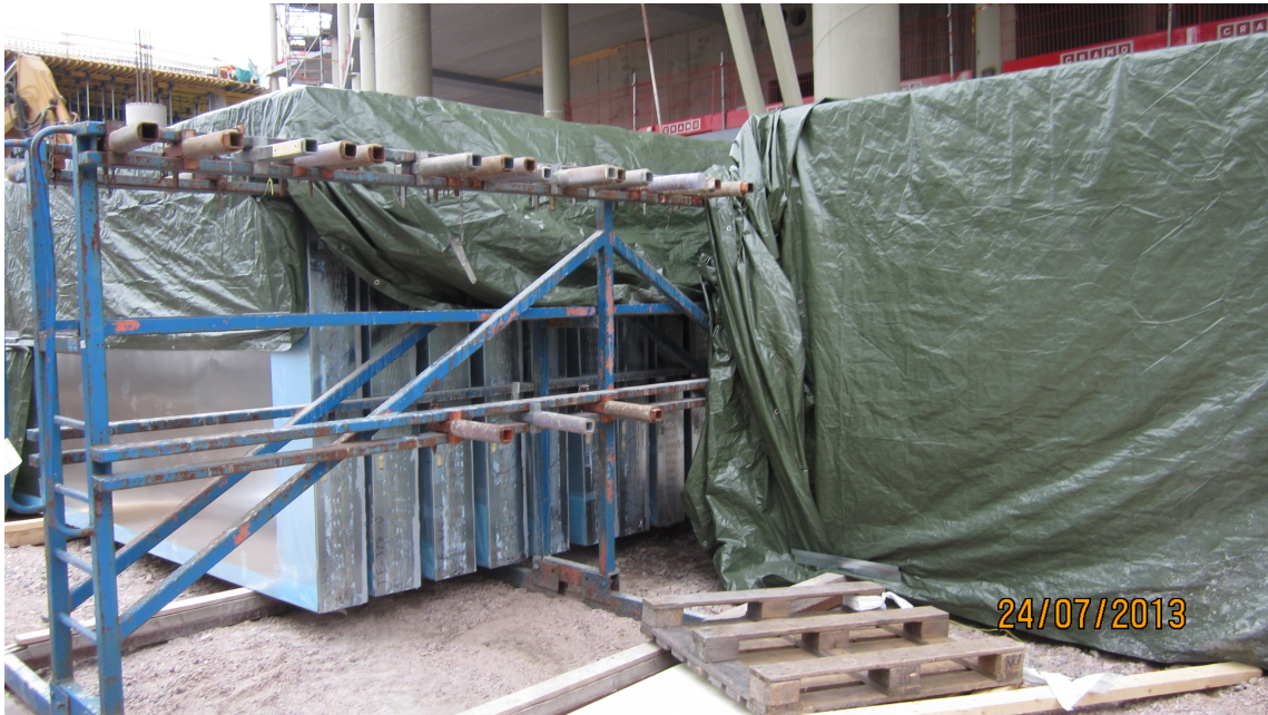
Kuva 9. Hyvin toteutettu julkisivuelementtien sääsuojaus Tikkurilan toimisto- ja liikekeskuksen työmaalla.
