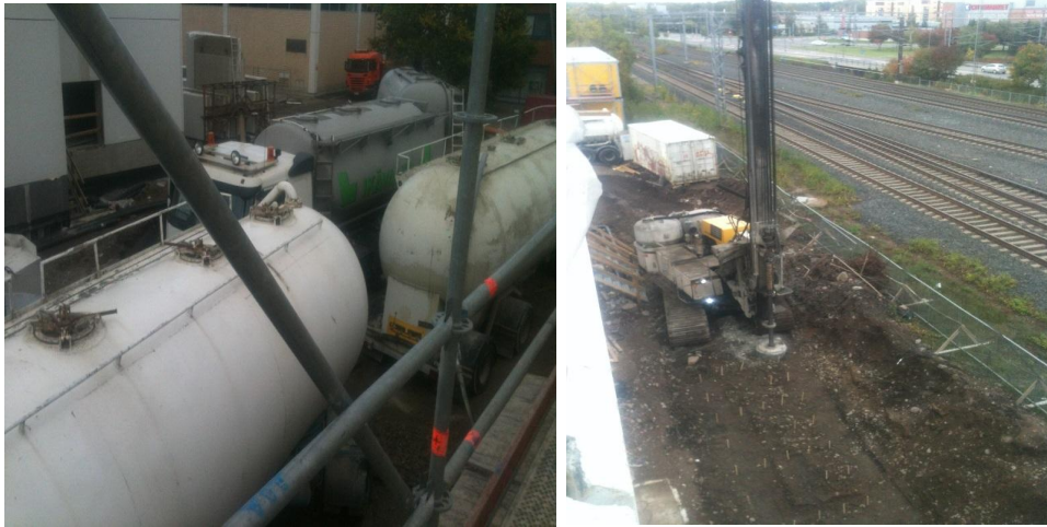
Kuvat 22 ja 23. Vasemmassa kuvassa stabilointityön kalustoa, johon kuuluu kalkki- ja sementtisäiliöt. Oikean puoleisessa kuvassa kaivinkone syöttää sideainetta kairan avulla maahan.
