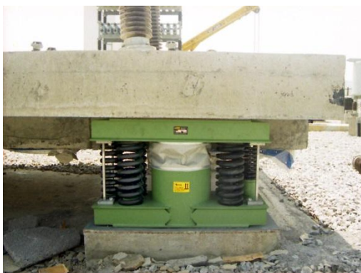
Kuva 15. Gerb-yhtiön teräsrousiratkaisu perustusten alle. (Verkkodokumentti 1.)
