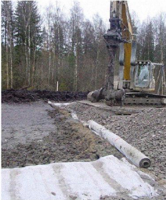
Kuva 10. Kuvassa massastabilointilaitteisto, johon kuuluu kaivinkone ja sekoitinlaite. (Hautalahti ym. 2007: 44.)
