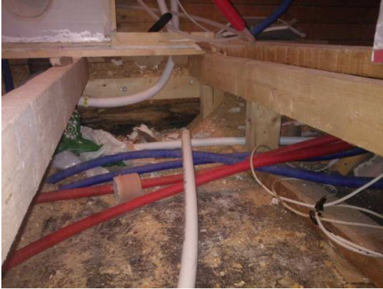
Kuva 22. Erillisen wc:n lattia aukaistu
