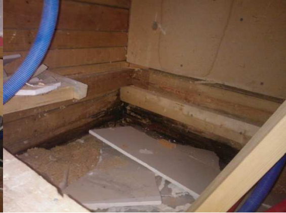
Kuva 23. Erillisen wc:n lattia aukaistu
