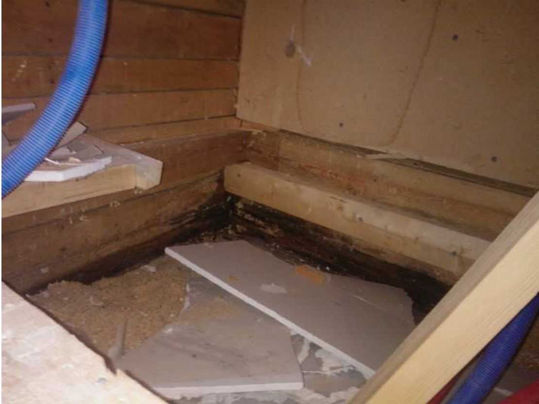
KUVA 13. Aukaistu alapohja wc:n osalla
