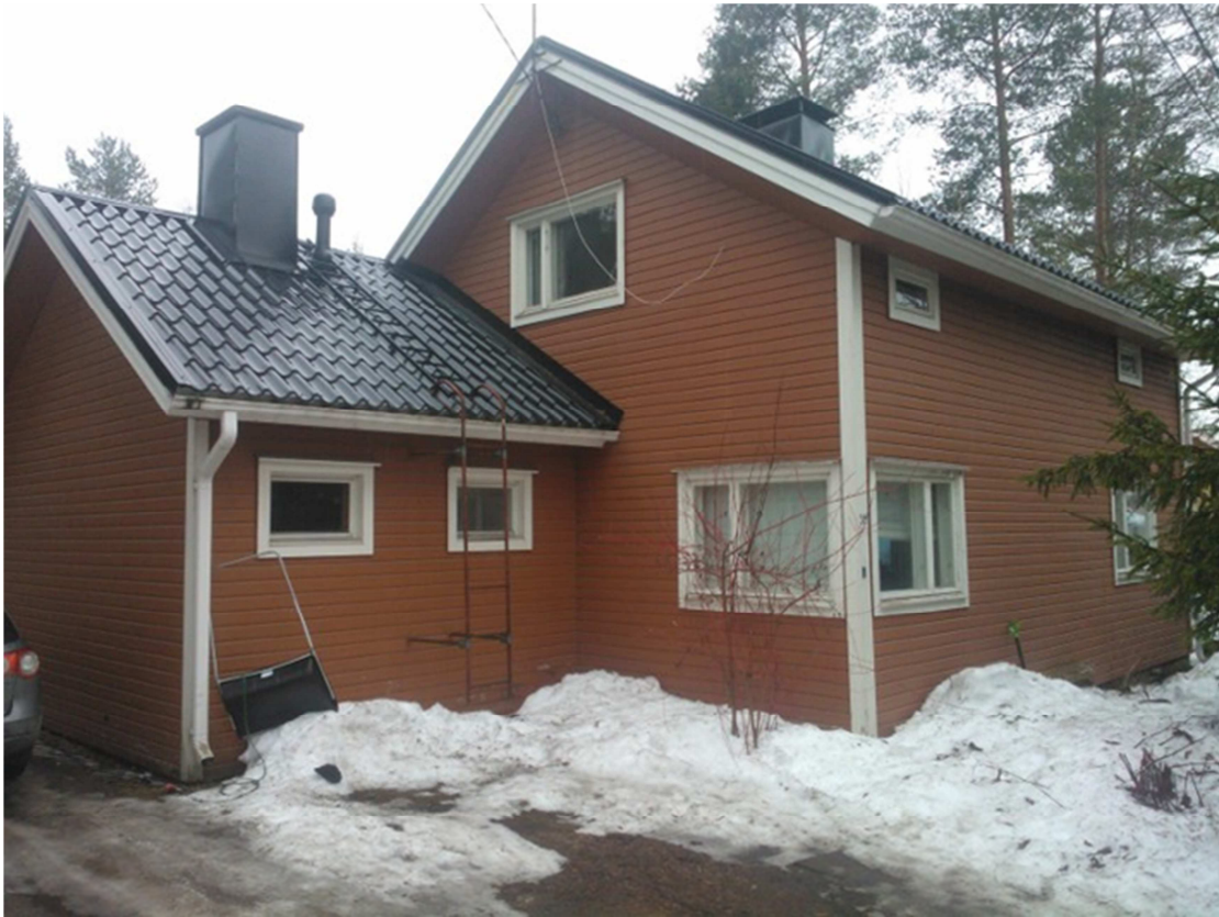
KUVA1. Kiinteistön julkisivu koillisesta
