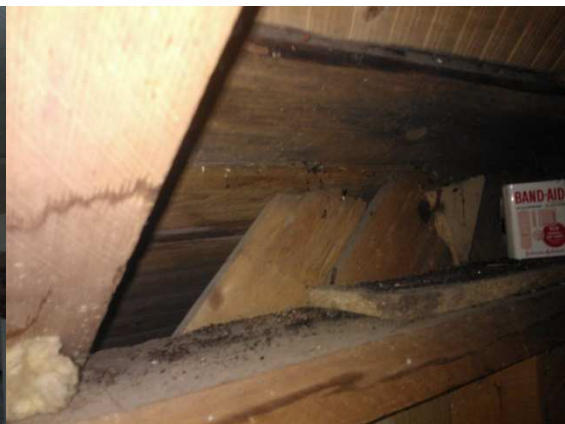
Kuva 27. Alkuperäisen osan seinä liitos
