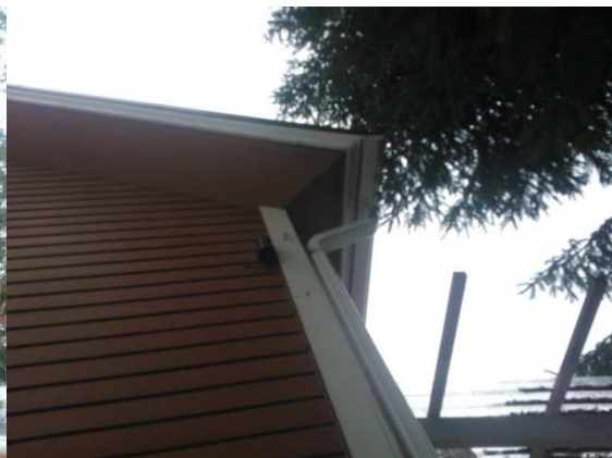
Kuva 7. Alkuperäisen osan räystäspohja
