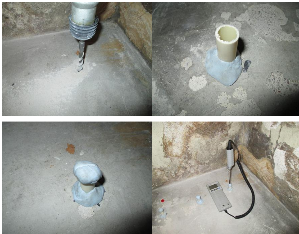
Bild 7. Fuktmätning med borrhålsmetoden (Fuktmätare Vaisala HMI41 med en HMP46 givare). (Bild Jonas Lindqvist)
