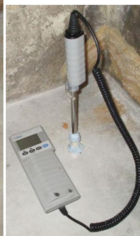
Bild 27. Mätning av fukt i Hål 1 (Bild Jonas Lindqvist)
