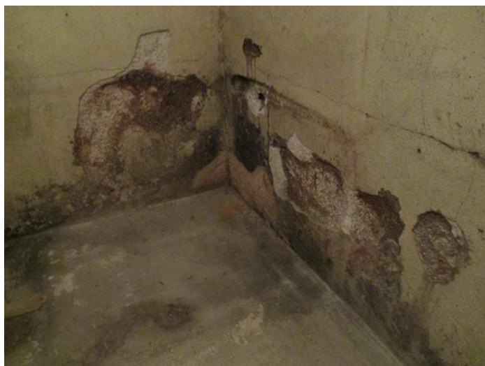
Bild 24. Källarväggen i hörnet där mätningen utförs. (Bild Jonas Lindqvist)
