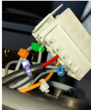
Kuva 18. Uuden liitinpohjan valmis johdotus
