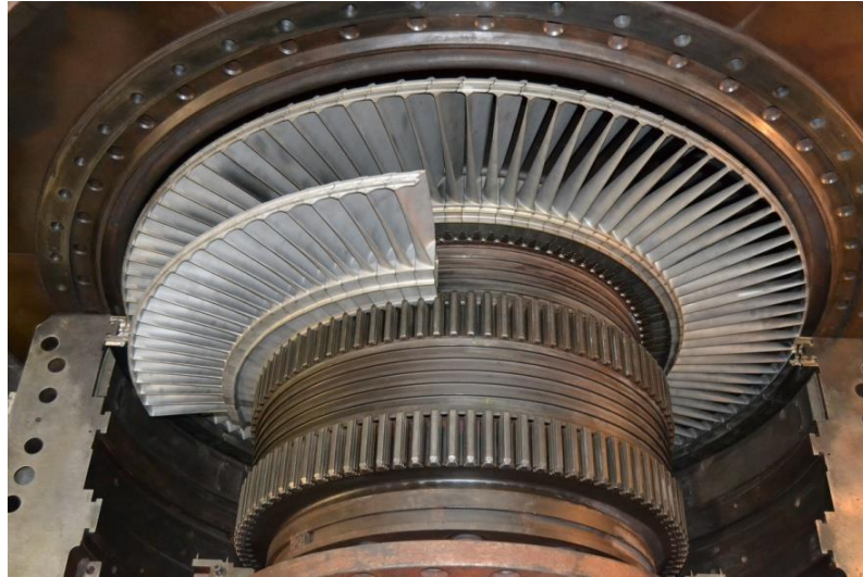
Kuva 6. Vanajan voimalaitoksen kaasuturbiinin akselin siipien uudelleenkiinnitys 2011 vuosihuollon jälkeen (kuva T. Koivikko).
