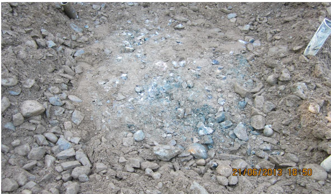
KUVA 22. Injektoinnin seurauksena syntynyt pilarimainen rakenne.
