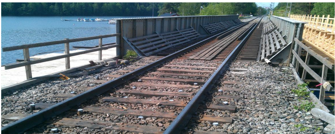
KUVA 14. Siuronkosken ratasilta ennen vahvistustöitä
