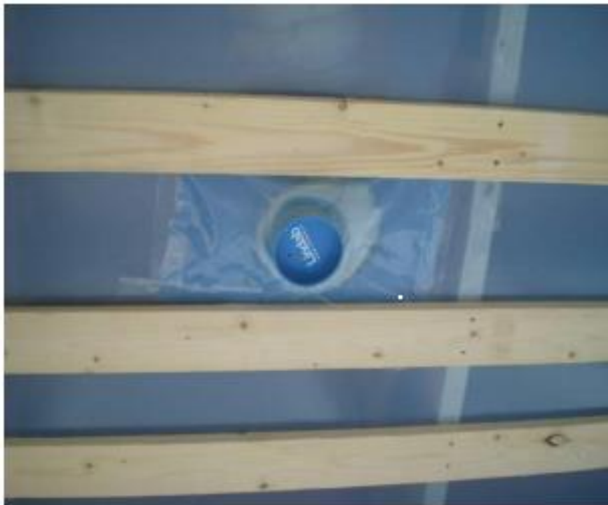
Kuva 5. Ilmanvaihtokanavan tiivistäminen höyrynsulkua vasten (Isopahkala 2011).
