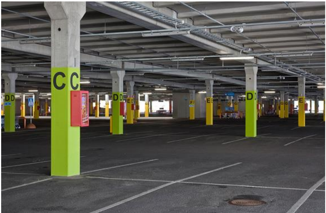
Kuva 10.1. Erään parkkihallin runkorakenteita. (Parma Oy)
