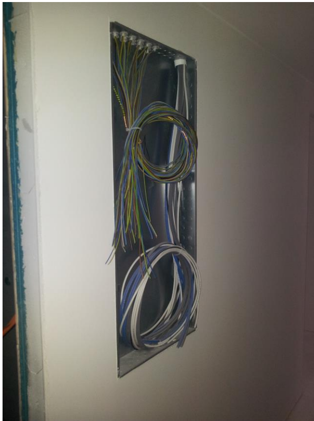
Kuva 7. Ryhmäkeskuksen runko väliseinässä. Kuva: Aleksi Valli
