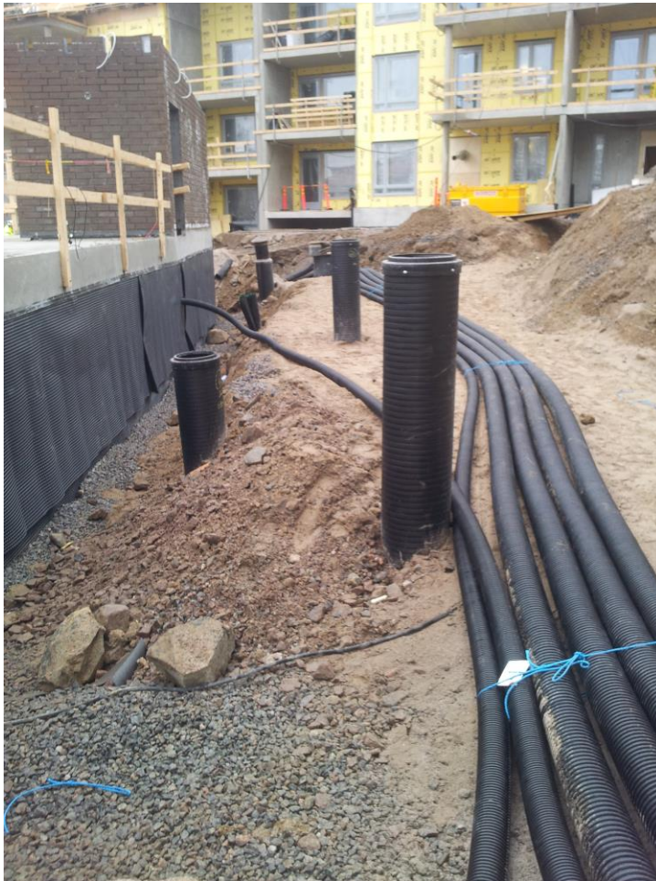
Kuva 4. Ulkopuolisia putkia ja kaivoja. Kuva: Aleksi Valli.
