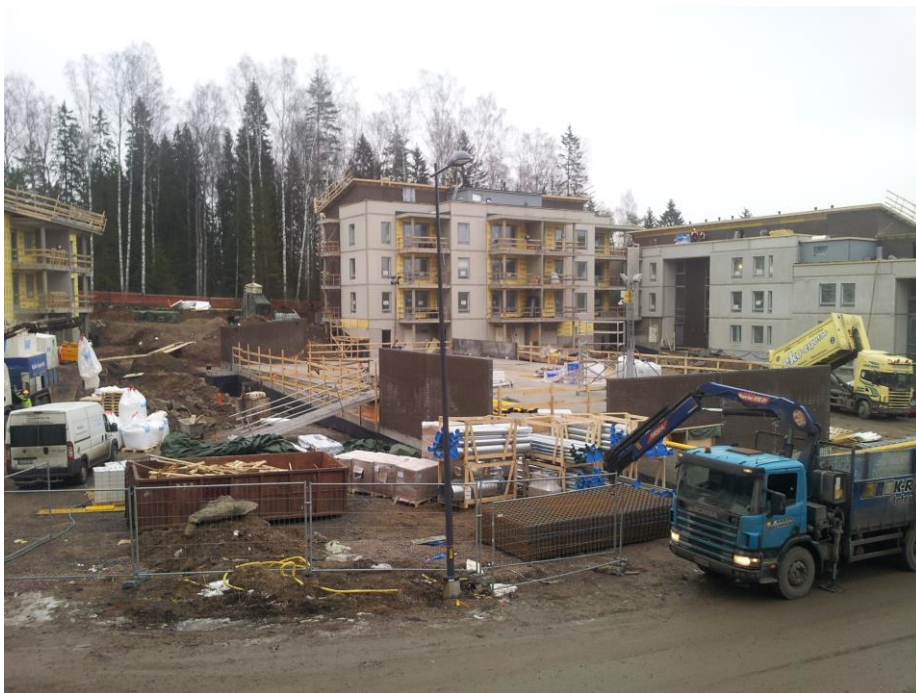
Kuva 1. As Oy Lotanmäki Espoon työmaa. Kuva: Aleksis Valli
