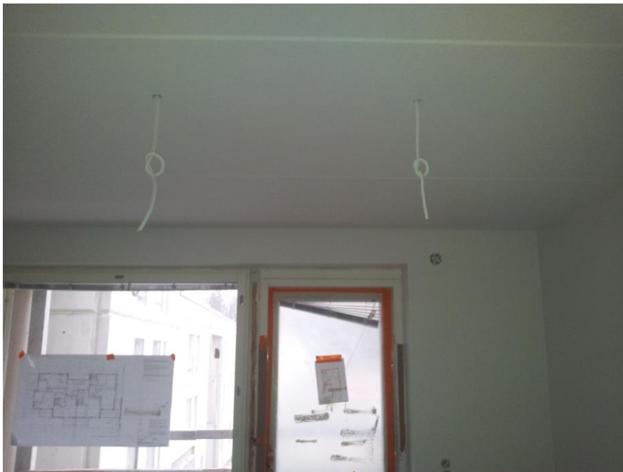
Kuva 10. Pinnat valmiiksi maalattuina, sähkökalustus voidaan aloittaa. Kuva: Aleksi Valli
