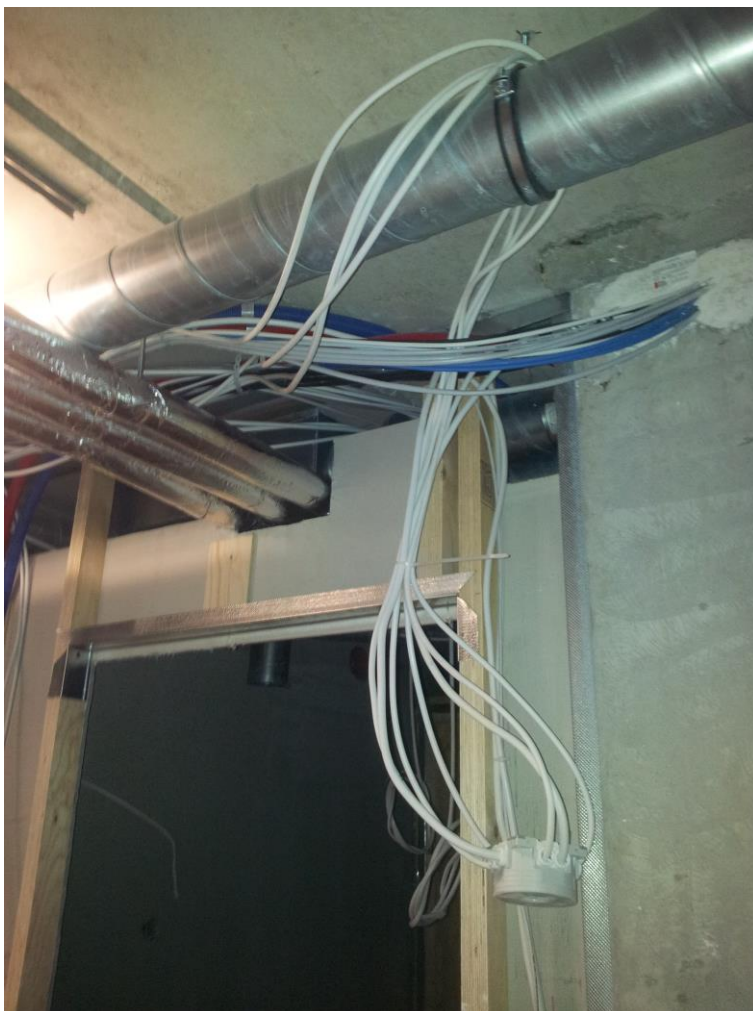
Kuva 8. Väliseinän ja alakaton johdotus kesken. Kuva: Aleksis Valli
