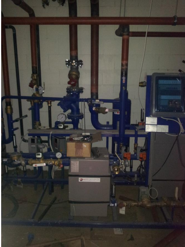
Kuva 11. Kyseisen kohteen lämmönjakohuoneen putkistoasennuksia. Kuva: Aleksi Valli.
