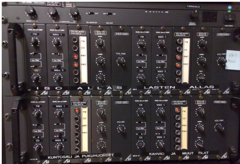
KUVA 6: Naisvuoren uimahallin analoginen moduulivahvistin
