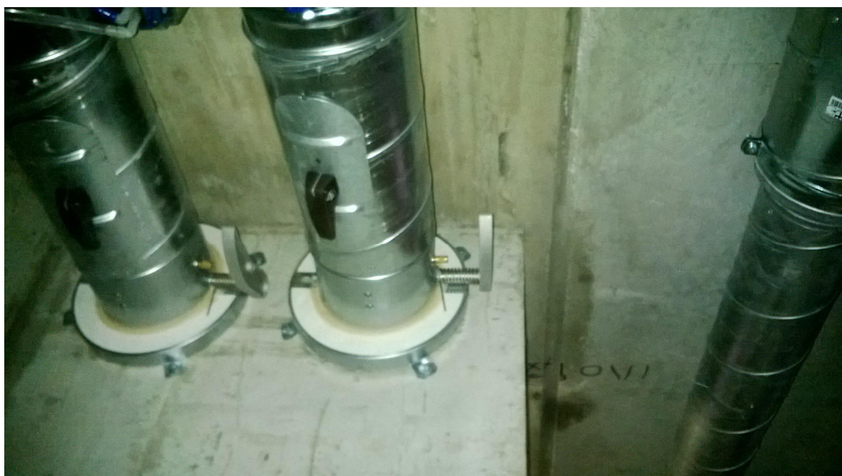
Kuva 7. Palopelti kiinnitetään seinään palopellissä olevista laipoista. Kuvan palopelti on auki asennossa ja sen yhteyteen on asennettu puhdistusluukku.
