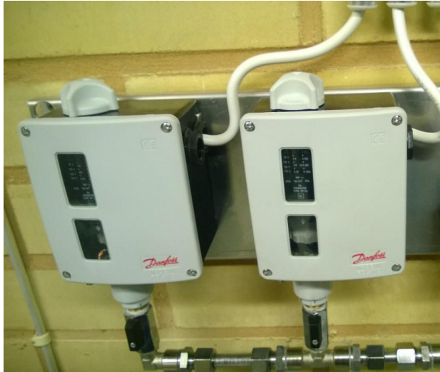
Kuva 5. Danfoss painekytkimet. (Kuva A.Haanpää 2014)
