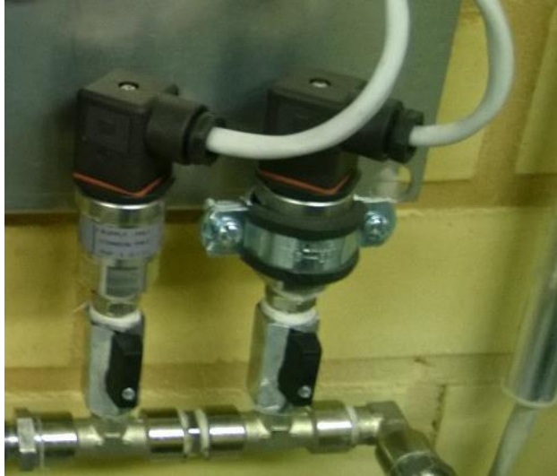
Kuva 4. Danfoss MBS painelähettimet. (Kuva A.Haanpää 2014)
