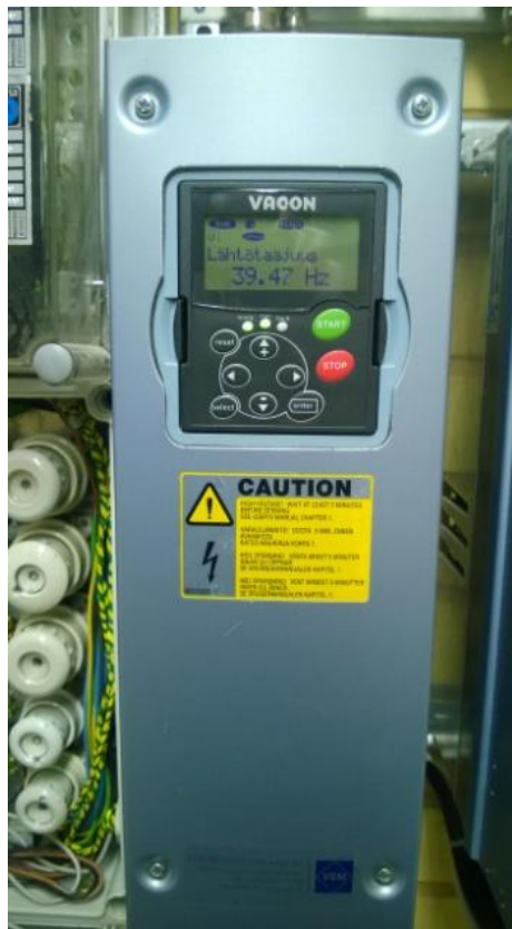
Kuva 3. Vacon NXS-taajuusmuuttaja. (Kuva A.Haanpää 2014.)
