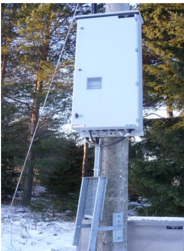
Kuva 2. Pylvääseen asennettu katuvalokeskus
