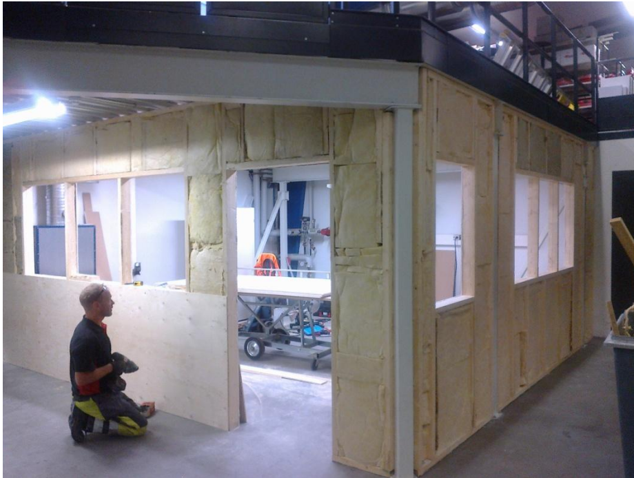
Kuva 5 Laboratorio rakennusvaiheessa (Würth Oy 2013.)
