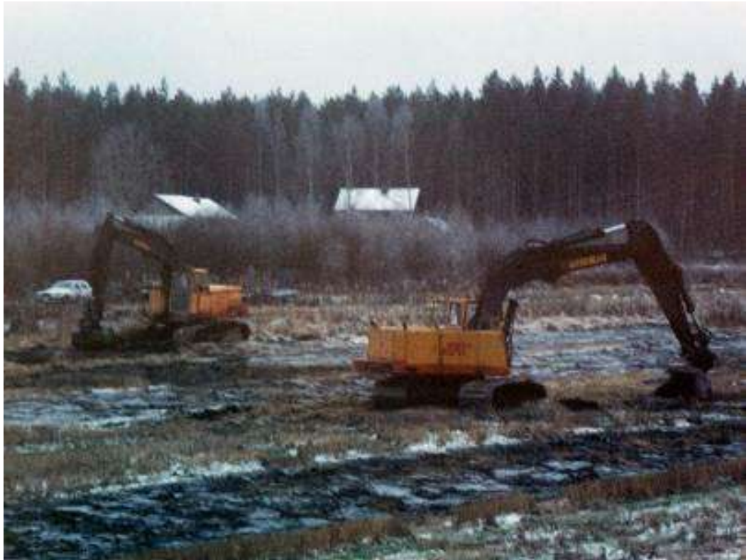
Kuva 1. Kaivinkoneet aloittamassa urakointia.
