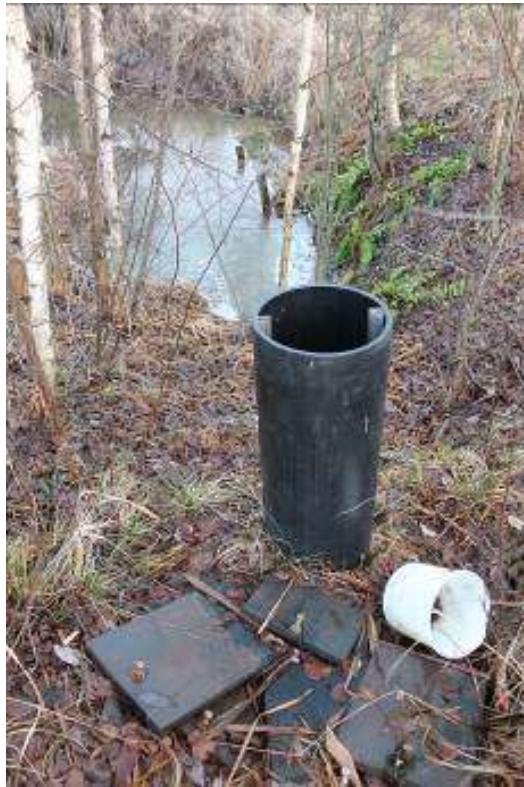
Kuva 8. Munkkiputki ja säätölevyt. Taustalla näkyy laskeutusallas.
