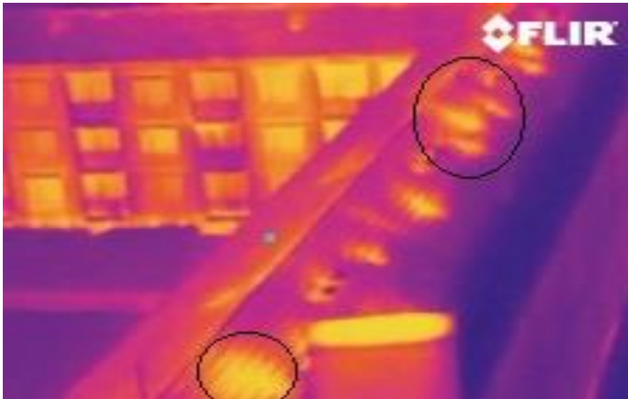
Kuva 19. Flir Tau -lämpökameralla otettu kuva kerrostalon kattorakenteista (Thermografien www-sivut 2013)
