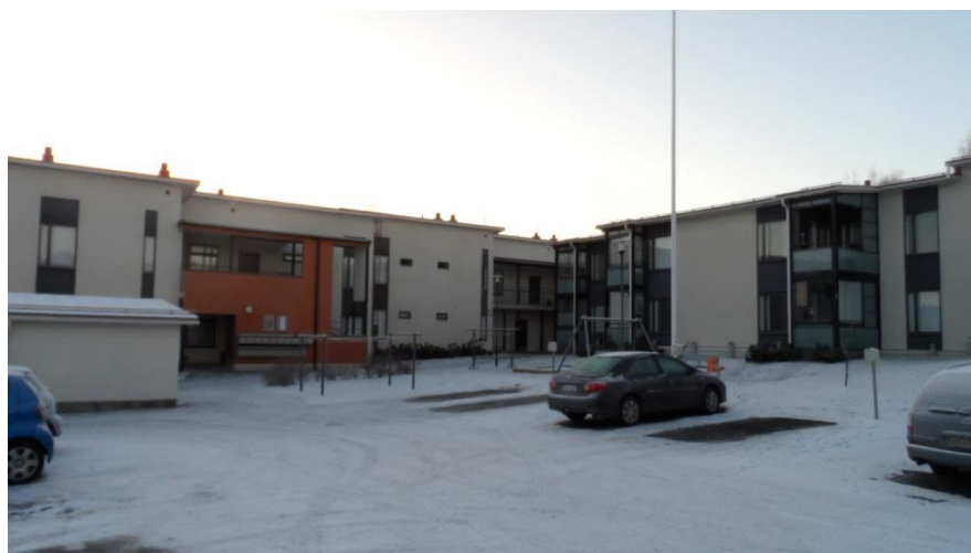
Kuva 3. Jyväskylän Samulinpuiston kiinteistö. Kuva: (Paalanen 2014-02-10).
