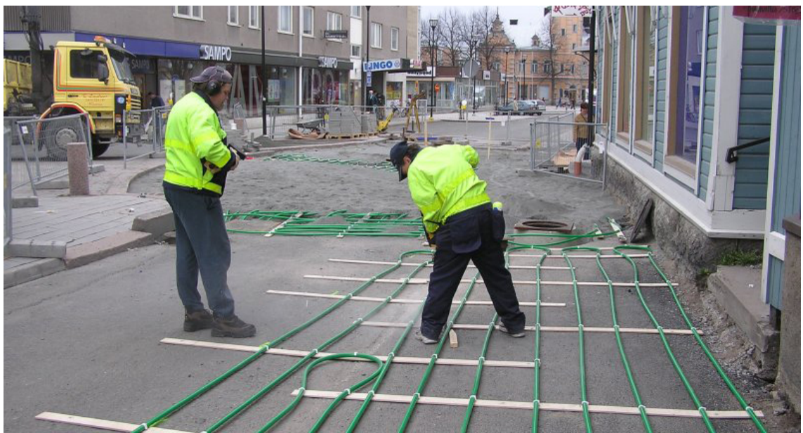
KUVA 1. Sulanapitoputkiston asennusta Kuninkaankadulla keväällä 2004 (Rauman kaupungin tekninen virasto 2004)
