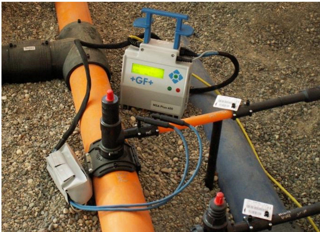
KUVIO 4. Virtalähde kytkettynä sähkömuhviosaan. (Vink Finland 2014)
