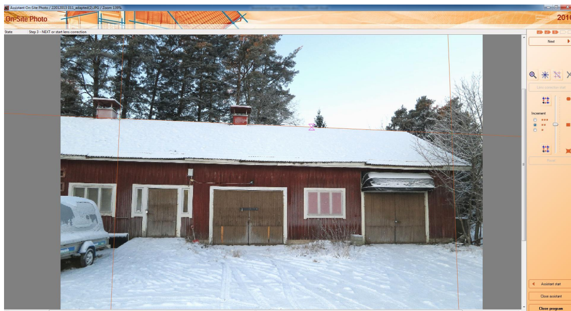
Kuva 31. Valokuvan linssivääristymän korjaus. Katon harjan, rakennuksen nurkan ja vasemmanpuolimaisen ikkunan pieleen on piirretty ohuet oranssit apuviivat.
