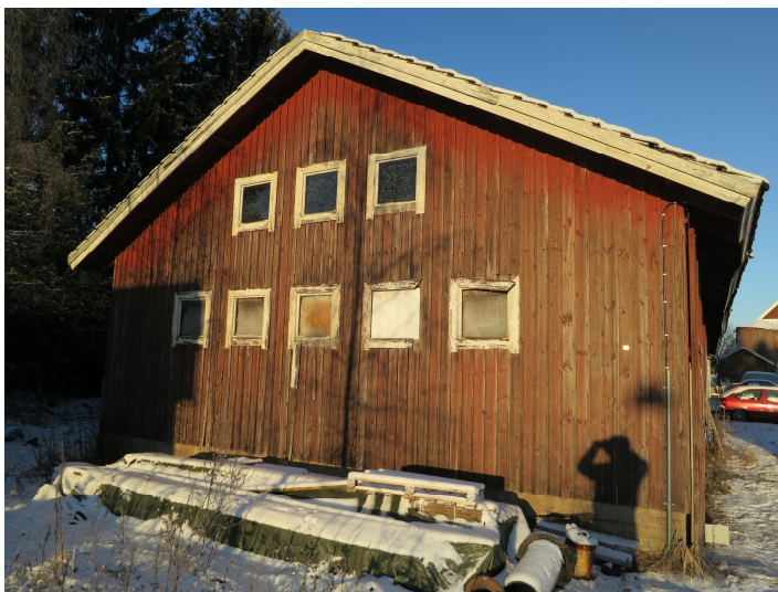
Kuva 28. Rakennuksen eteläpääty. Mitattu ikkuna on alarivissä toinen vasemmalta [42].
