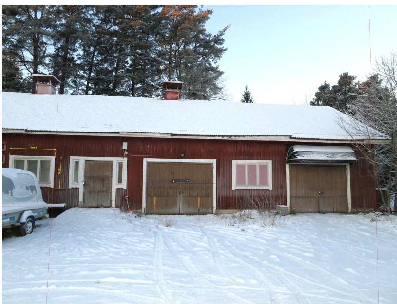
Kuva 33. Mittavalmis kuva. Vasemmanpuolimainen ikkuna on mitattu keltaisilla mittaviivoilla, leveydeksi ja korkeudeksi saatiin 1880,5 mm ja 1373,9 mm.
