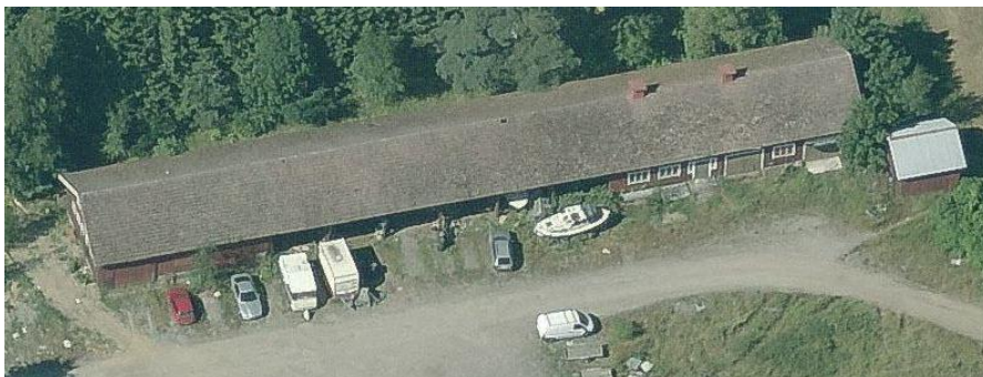
Kuva 20. Ilmakuva Sandkullan konesuojasta. Kuvan oikeassa laidassa oleva varasto ei kuulunut toimeksiantoon [41].
