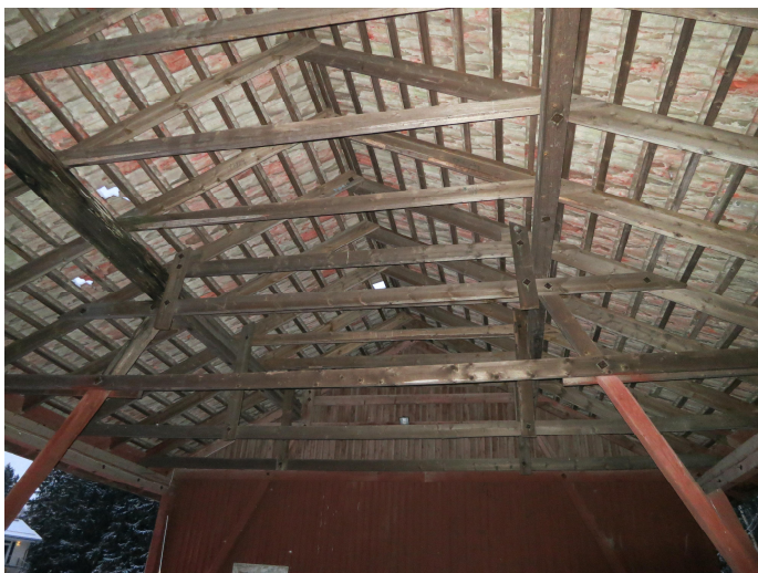
Kuva 29. Kylmän katoksen rakenteita [42].
