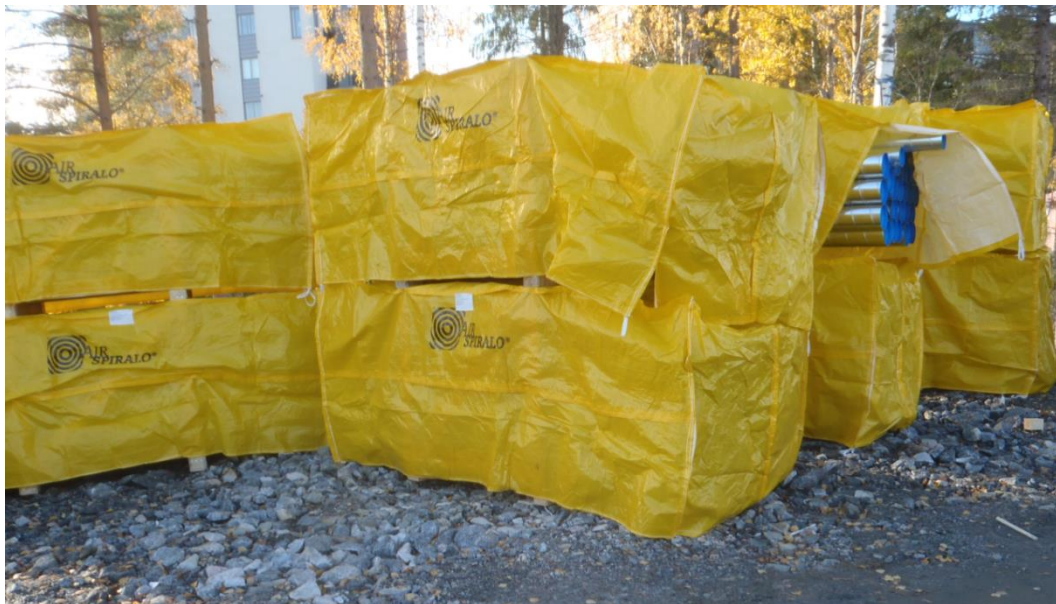
KUVA 2. Materiaalin säilytys työmaalla (Ohtonen 2014-3-27.)
