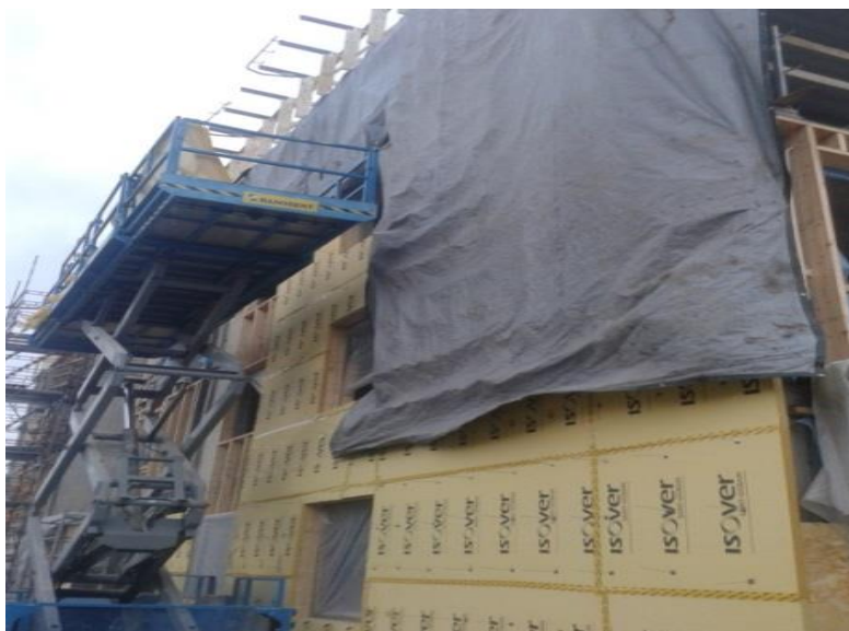
KUVA 4. Keskeneräisen seinän suojaaminen (Ohtonen 2013-7-10.)
