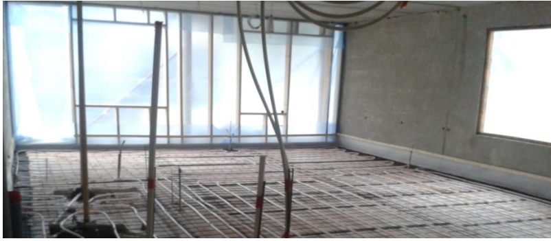
KUVA 6. Ulkoseinä ja ikkunaaukkojen suojaus (Ohtonen 2013-7-25.)
