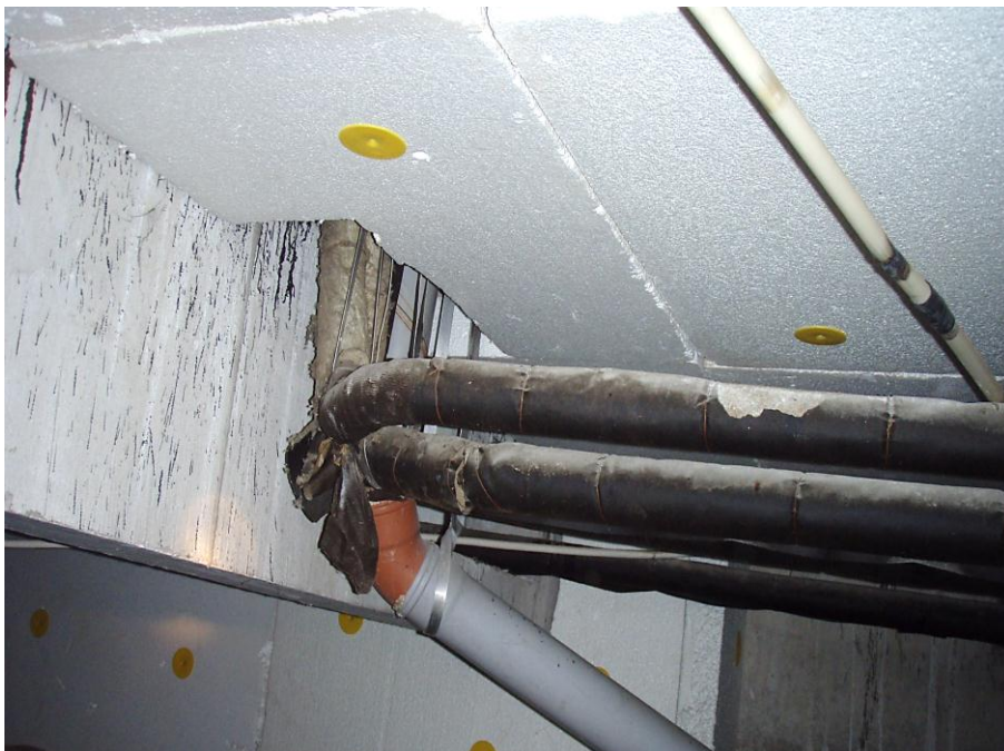
Kuva 26. Karkaistun kevytbetonialapohjan alapintaan asennetut eristyslevyt [13].
