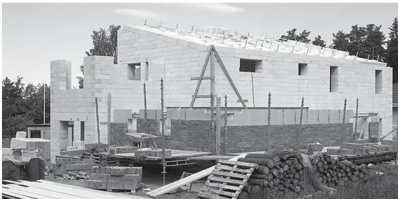
Kuva 2. Höyrykarkaistusta kevytbetonista rakennettu pientalo [4, s. D1].
