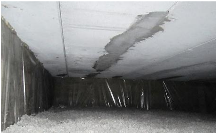
Kuva 25. Karkaistun kevytbetonialapohjalankun laastipaikkaus [13].
