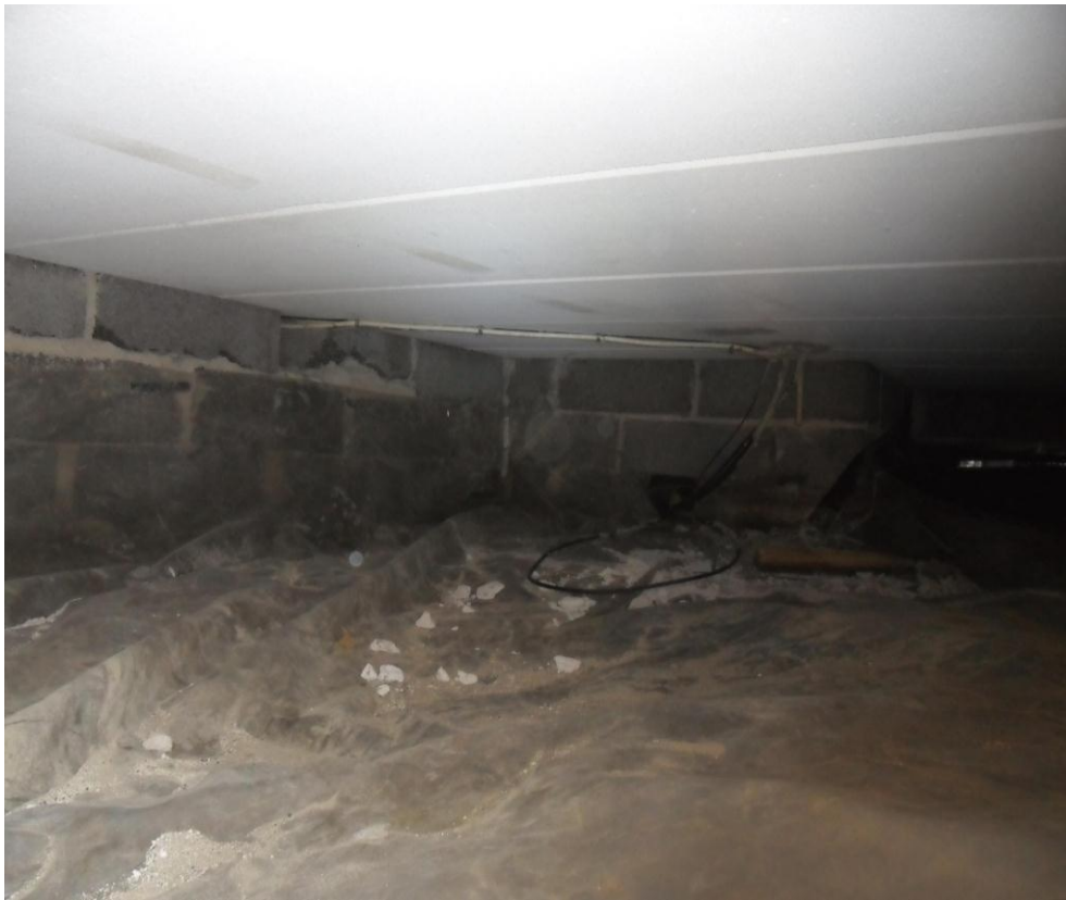
Kuva 18. Muovilla suojattu ryömintätilan osa.
