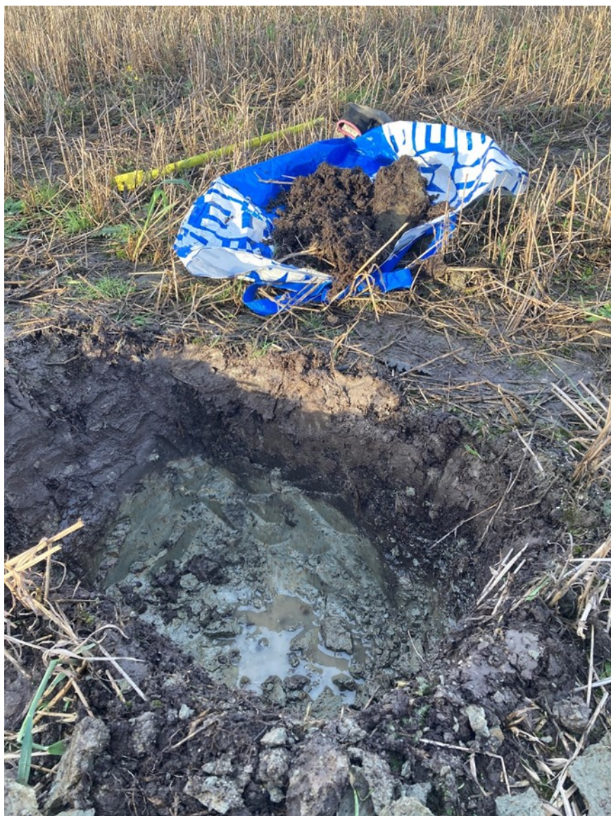
Kuva 26. Kaivettu näytekuoppa numero 1.
