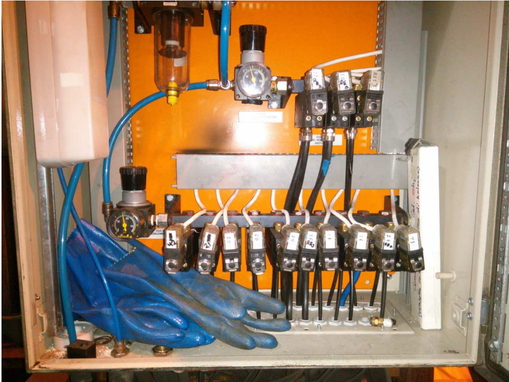
Kuva 8. Magneettiventtiilikotelo A7
