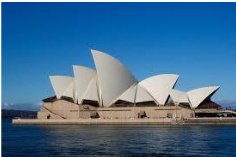
Kuva 3. Sydneyn oopperatalo, Australia. Mikkeliäinen Savcor Oy suoritti betonirakenteiden katodisen suojauksen. Kuva Savcor Oy
