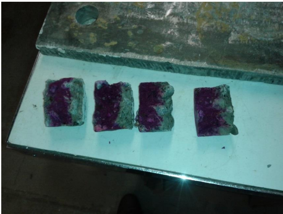
Kuva 5. Fenoliftaleiiniindiliuoksella käsitellyt näytekappaleet. Näytepalat parvekekaiteen sisäpinnasta. Värjäytymätön osuus betonissa on karbonatisoitunut. Kuva Markku Partanen
