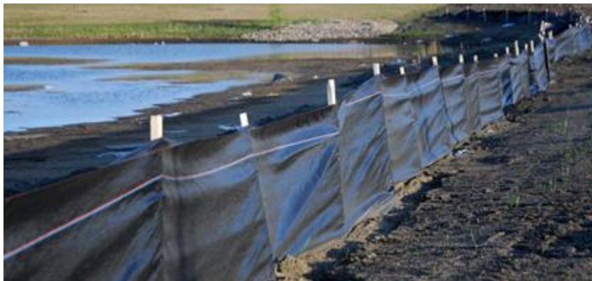
Kuva 3. Rakentamisaikaisen kiintoainekuormituksen vähentämistä varten asennettu suojaus ( silt fence ) http://www.nilex.com/products/sediment_control/silt_fence
