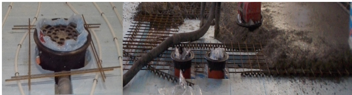
Kuva 18. Lisäraudoitukset kaivon ympärillä ja aukon kohdalla
