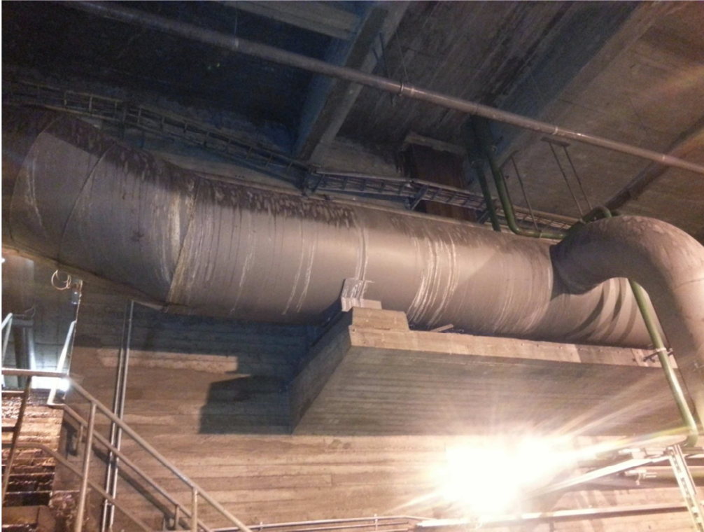
KUVA 17. 10. position pumppujen jälkeinen putkiosuus ennen putkitunnelia
