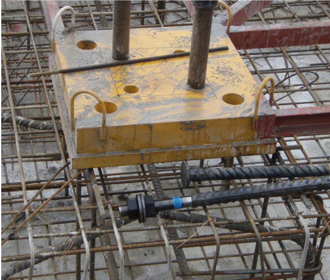
Kuva 22. Perustuksen ja tuentakehikon välinen pulttiliitos [kuva, Jan Wallenius].
