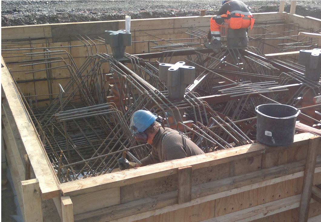
Kuva 2. Maanvaraisen laattaperustuksen raudoitustyö [kuva, Petri Rantanen].
