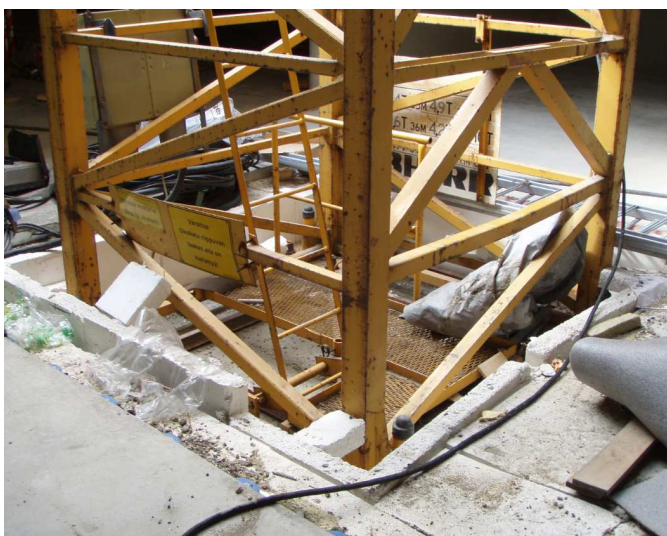
Kuva 42. Kuvassa torninosturi perustukseen kiinnitettynä [kuva, Jan Wallenius].
